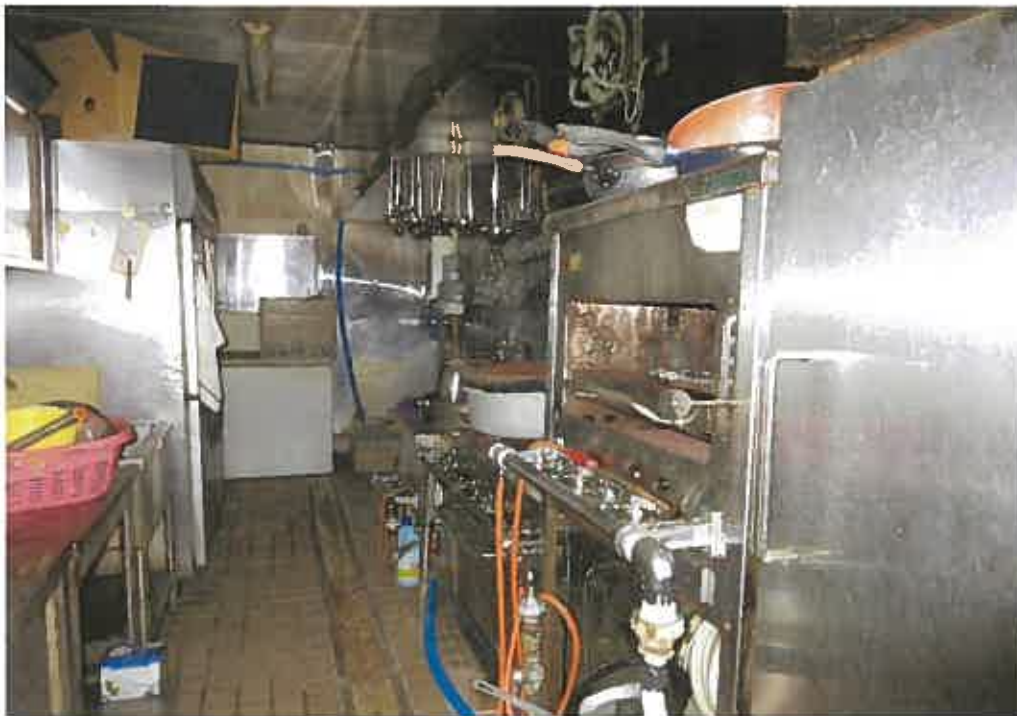
物件12:1階厨房の状況
