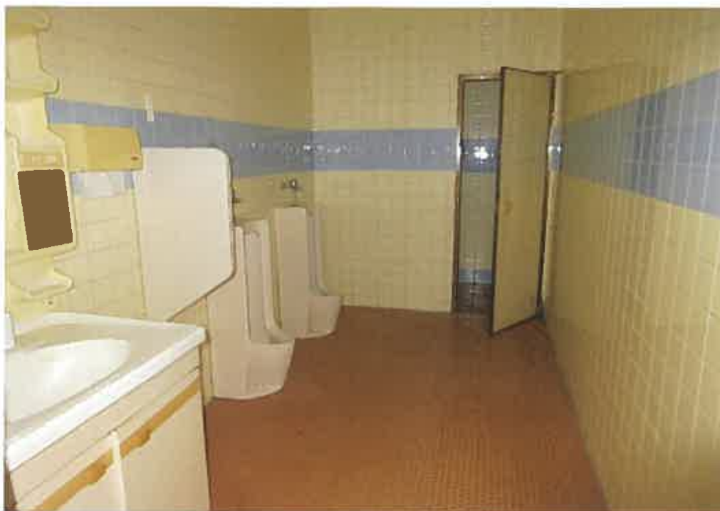
物件12:2階便所の状況
