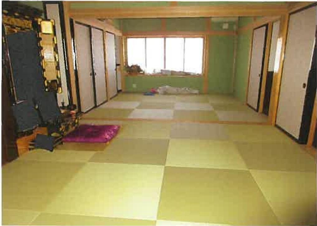
物件25主である建物:1階和室2間の状況
