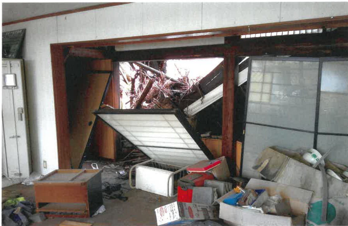
写真⑦(物件 1 3 建物内部)
