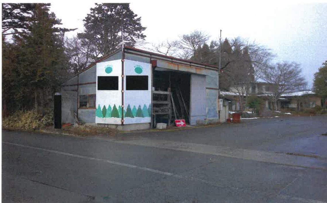
写真⑥(物件3 土地上 附属建物①)
