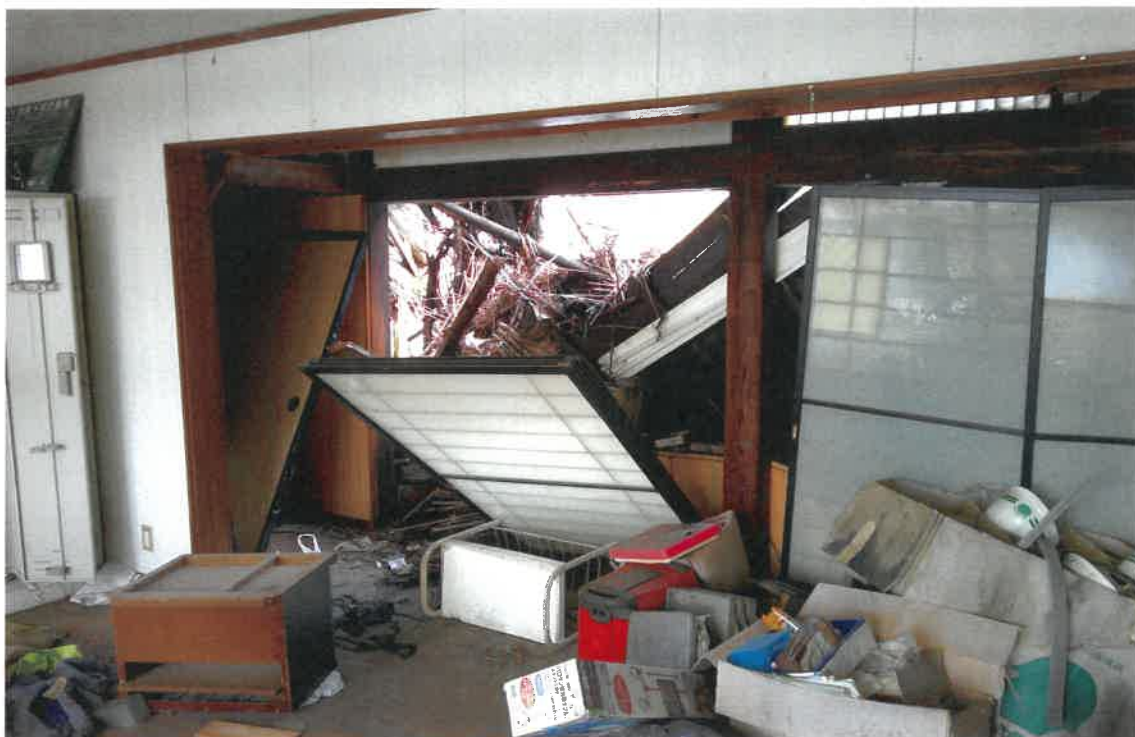
写真⑦(物件13 建物内部)
