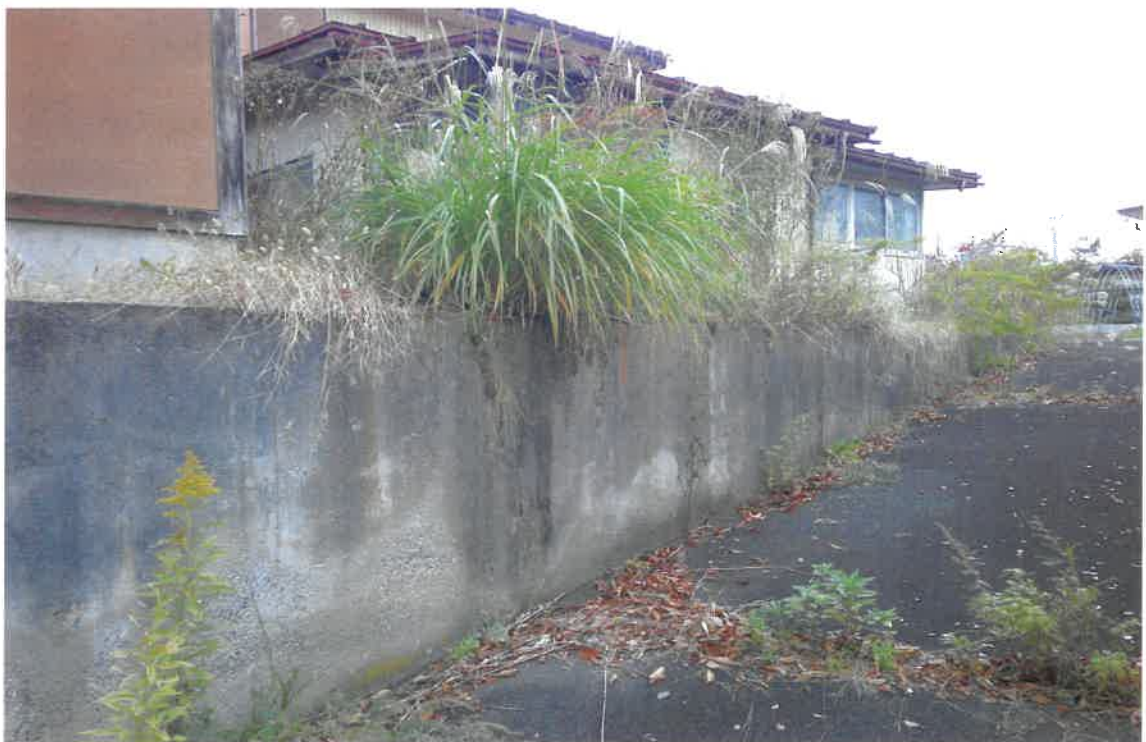
写真② (物件3 東側境界付近)
