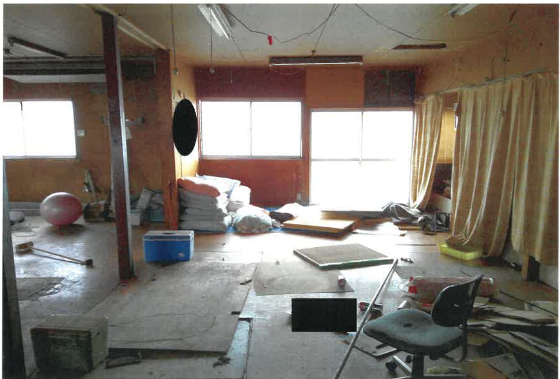
写真④(物件4 1階 作業場東側)
