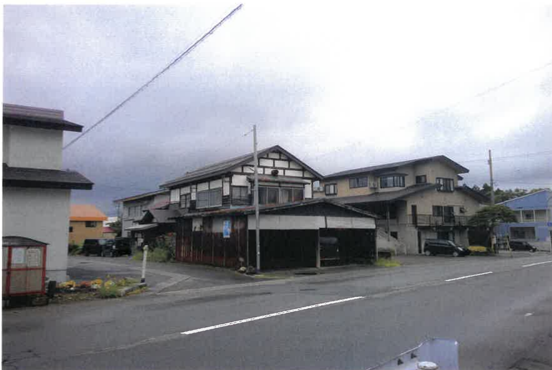
写真①（物件 1 及び目的外建物北側外観）
