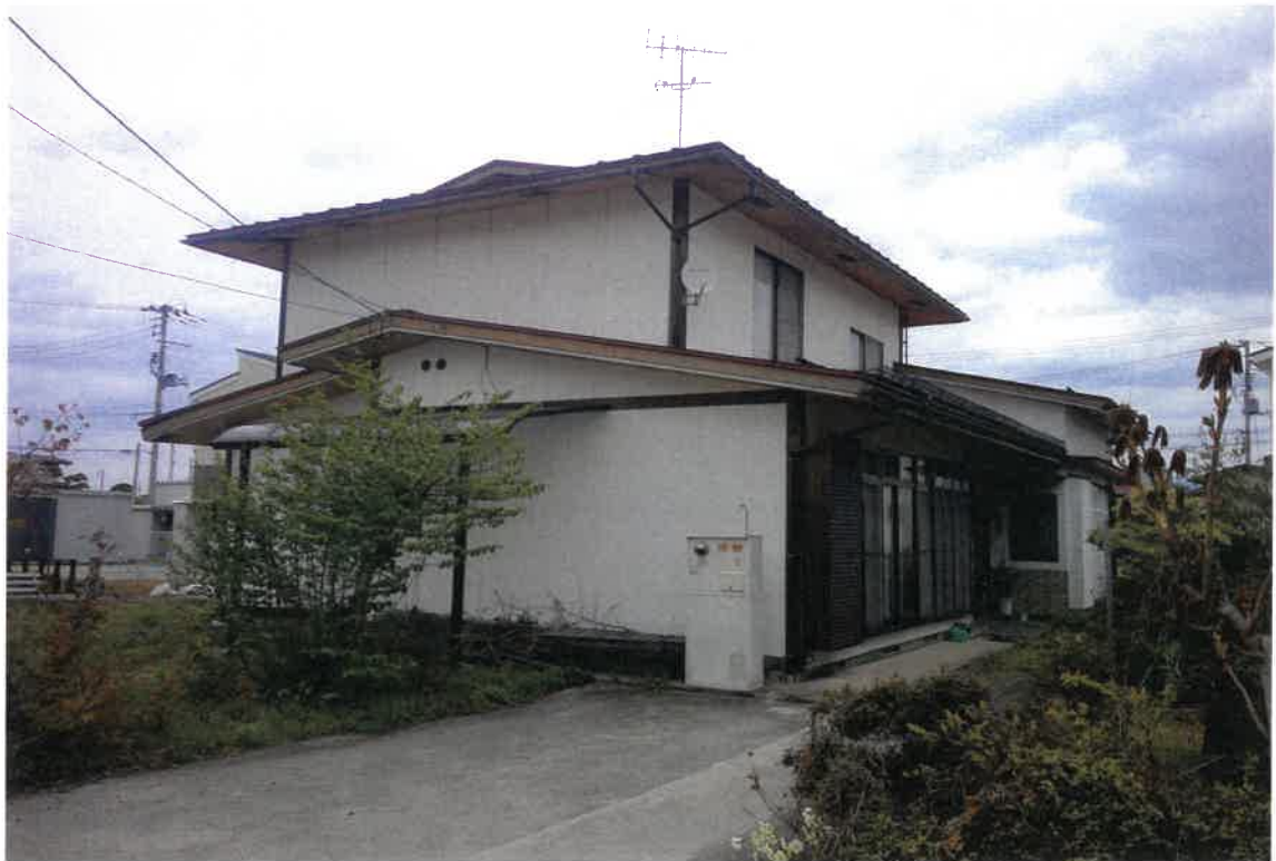
写真① (物件 2 の土地 目的外建物外観)
