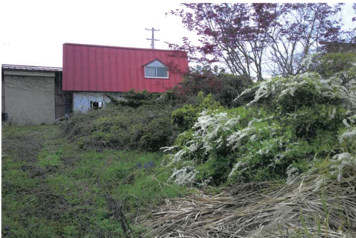
写真② (物件 1 と 2 の境界付近)
