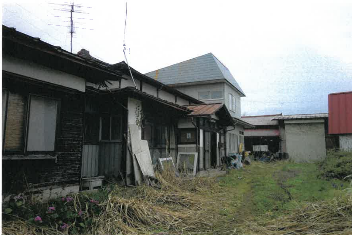
写真① (建物外観)
