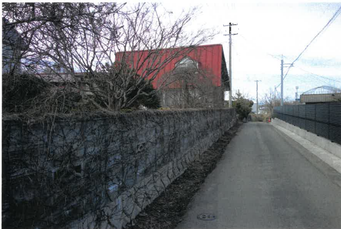
写真③ (物件2 東側境界付近)
