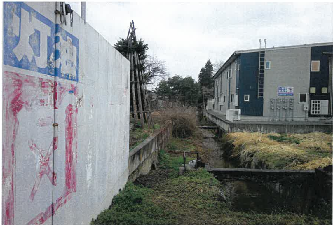
写真⑩(物件1及び2 南側水路付近)
