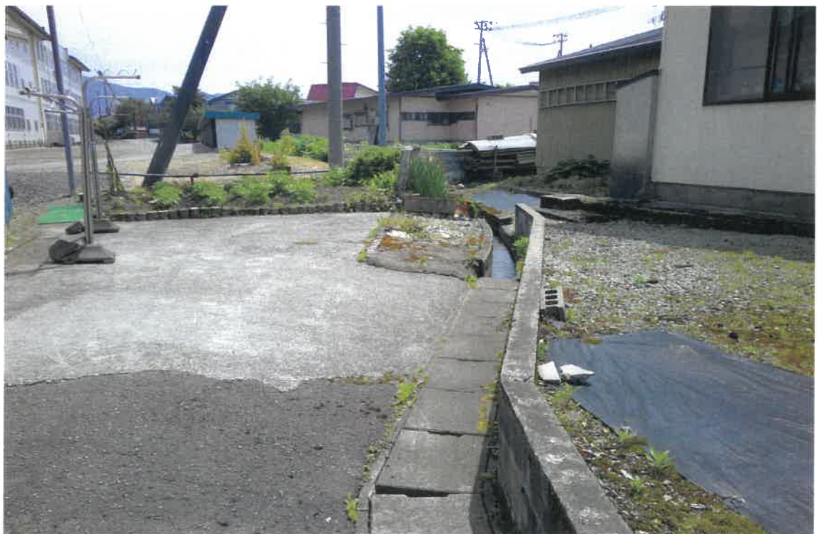
写真② (物件1 南側境界付近)
