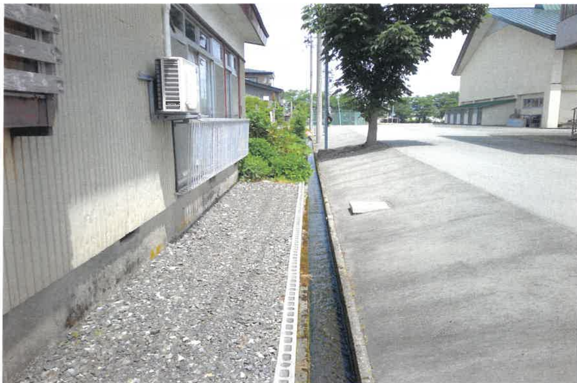
写真③(物件1 東側境界付近)
