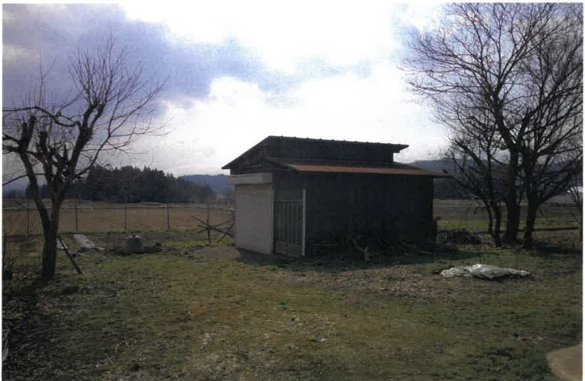
写真⑥ (仮設物置)
