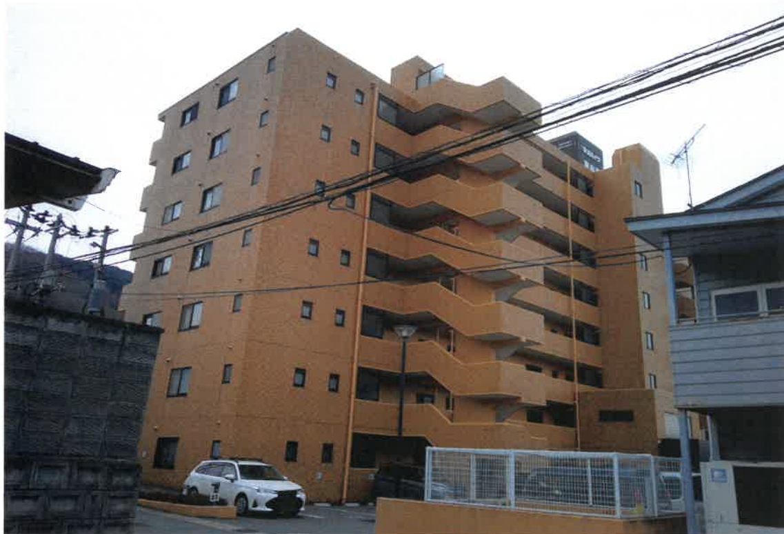
写真①（建物外観）
