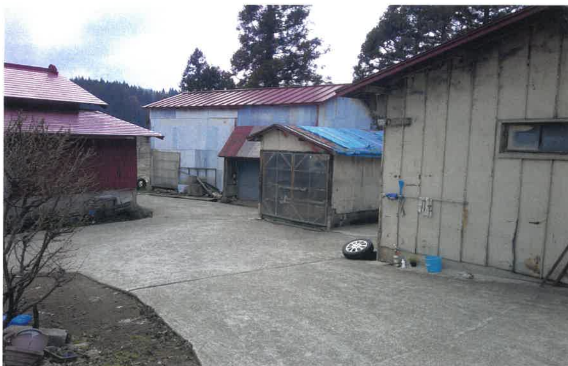
写真②(物件2、3付近)
