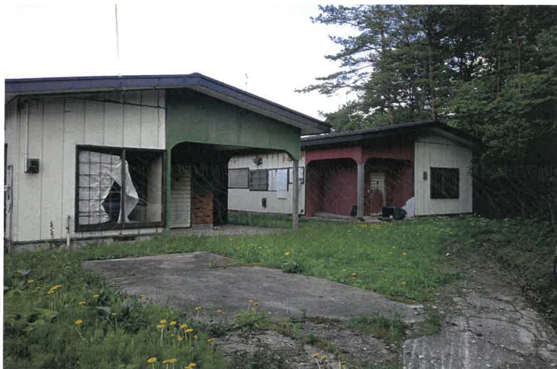
写真①(物件3及び4 建物外観)
