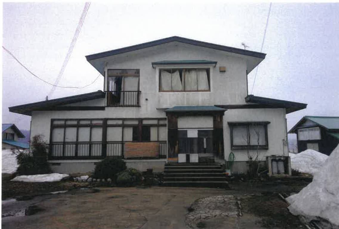
写真①(建物外観)
