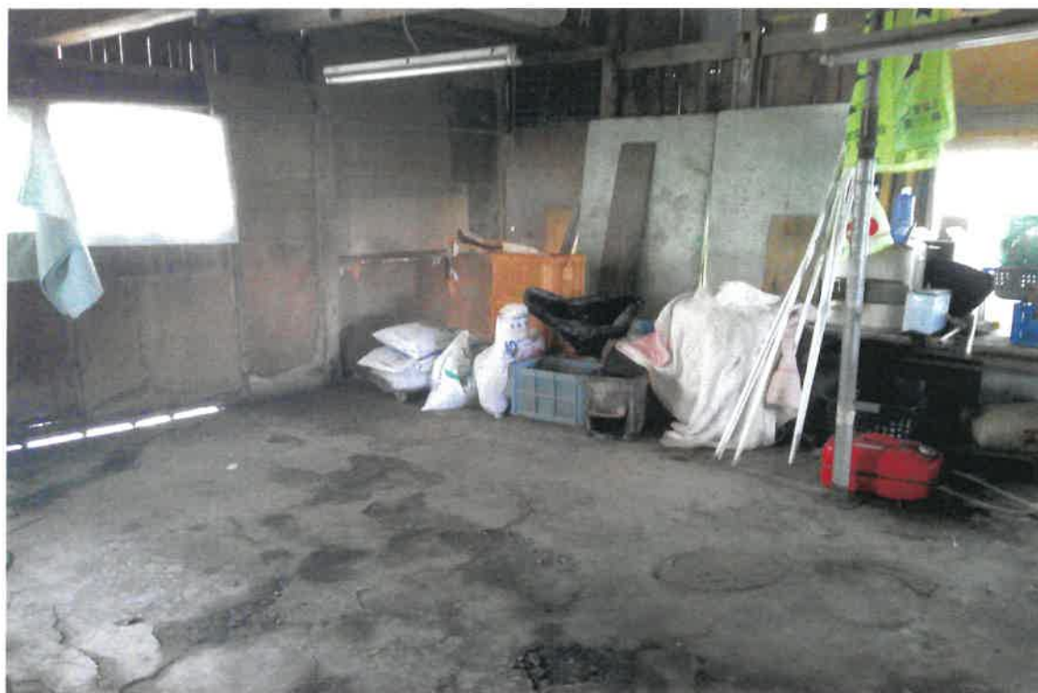
写真⑨ (仮設物置 建物内部)
