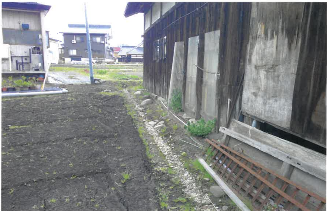
写真⑧(仮設物置 側面部分)
