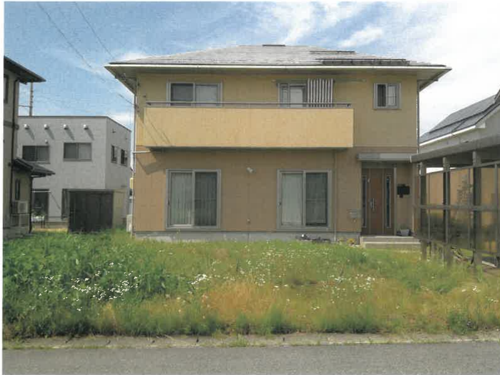
写真① (建物外観)
