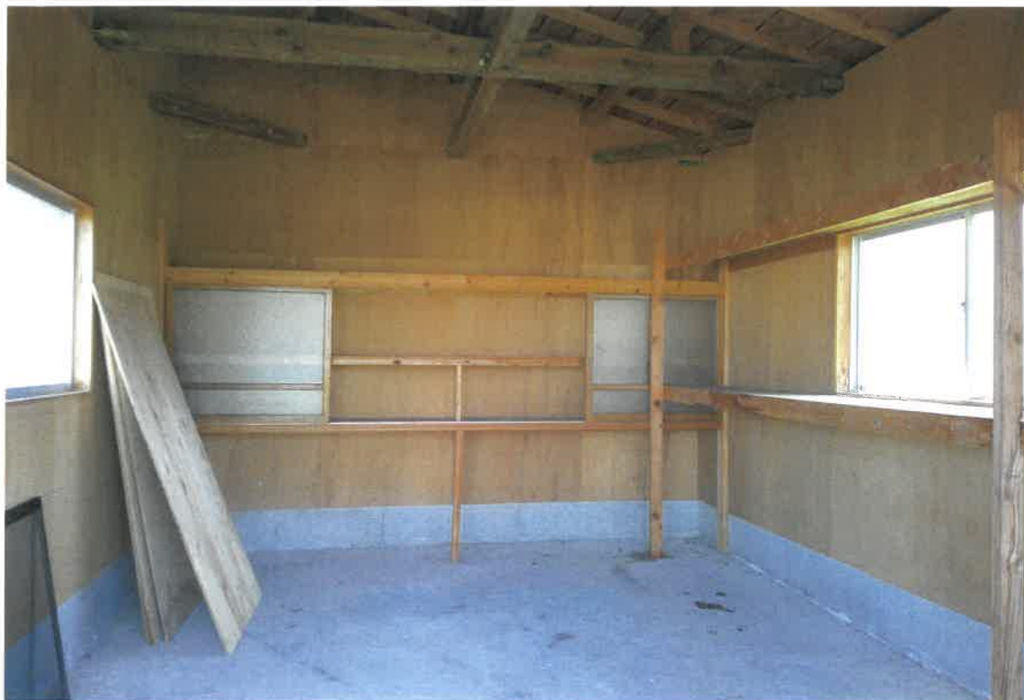
写真⑦(物件2 附属建物内)
