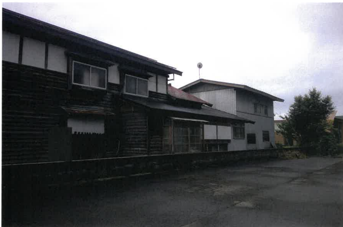
写真②（物件 1 北西側境界付近及び目的外建物 1 と 2 北西側外観）
