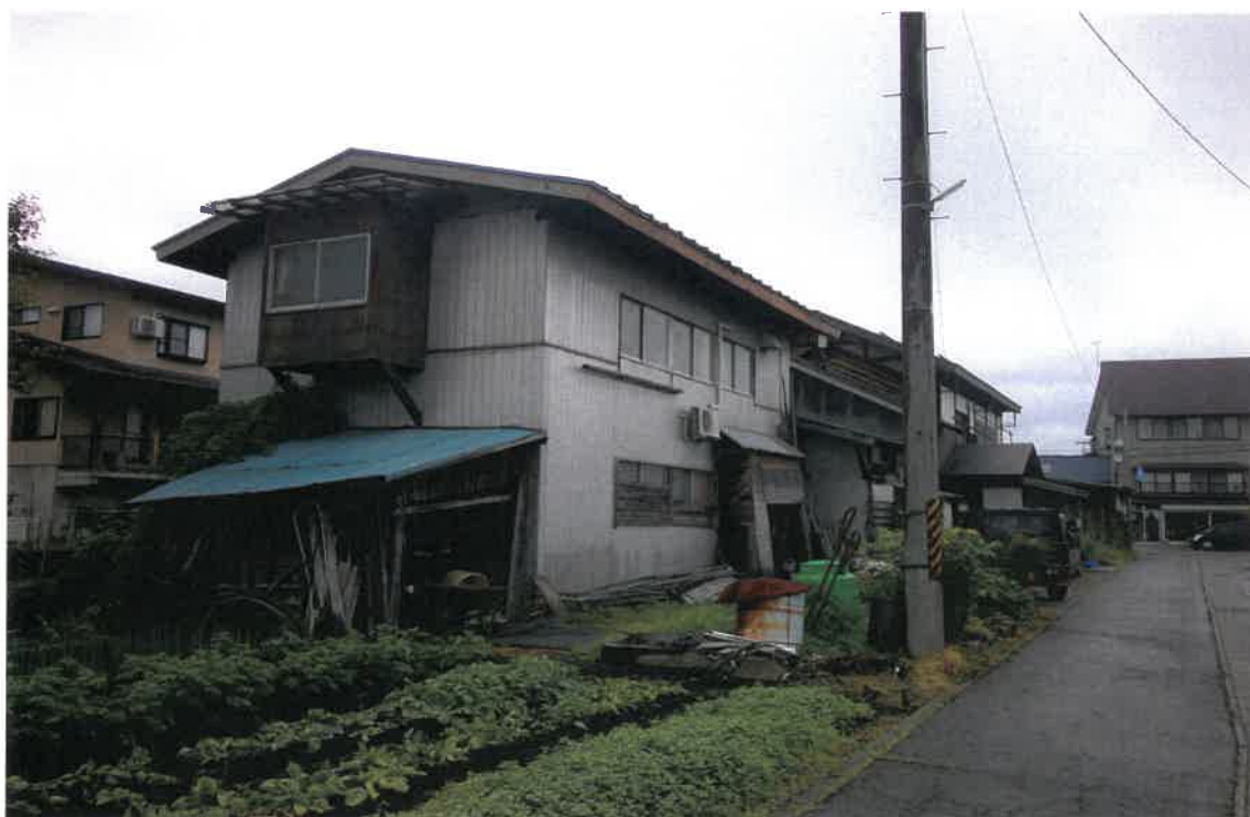
写真④（物件1 南側境界付近及び目的外建物2 南側外観）
