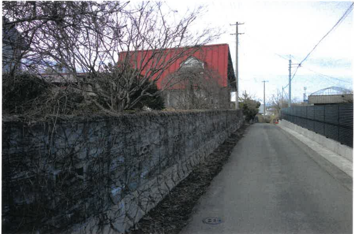
写真③(物件2 東側境界付近)
