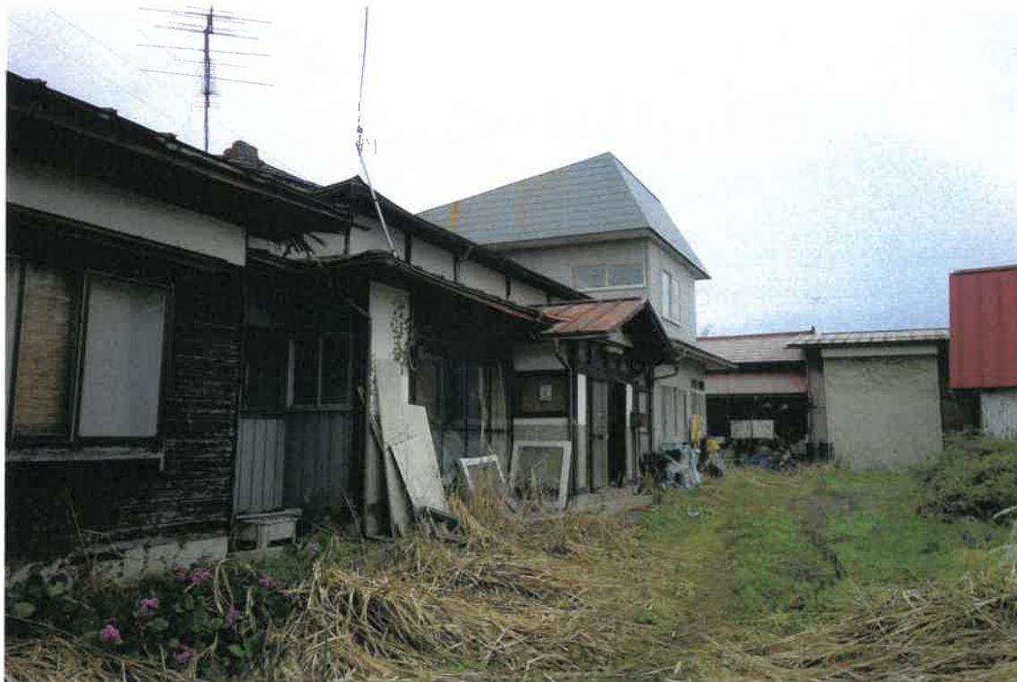
写真① (建物外観)
