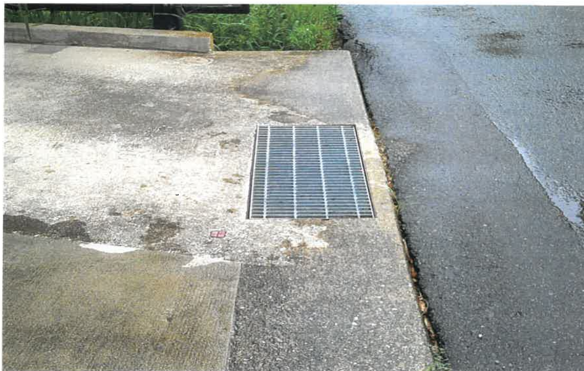
写真④ (物件 1 西側境界付近)
