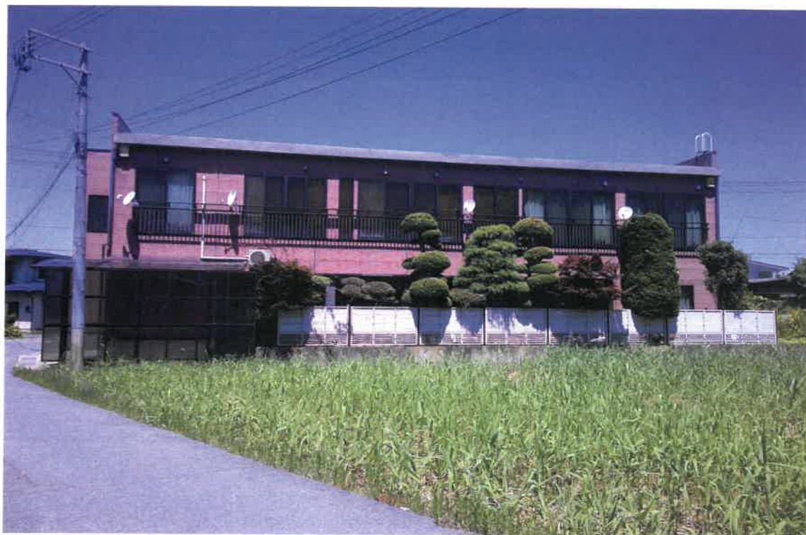
写真②(建物外観 南側)
