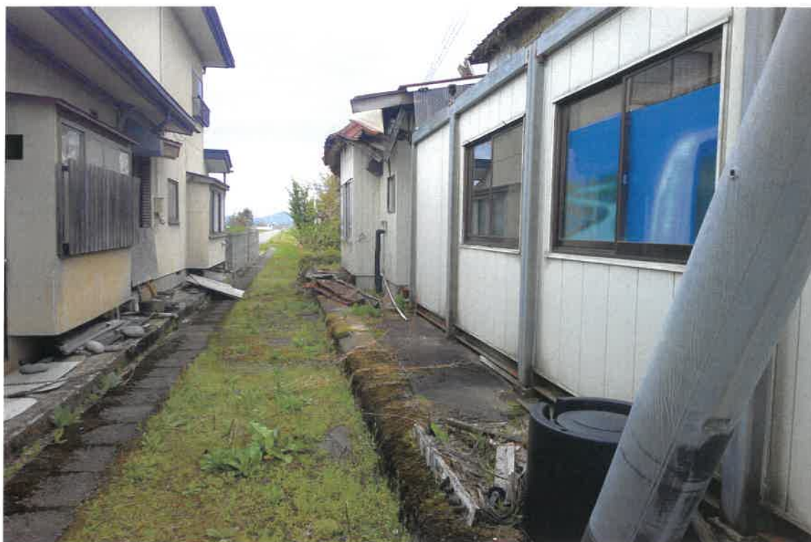
写真③ (物件 1 北西側境界付近)
