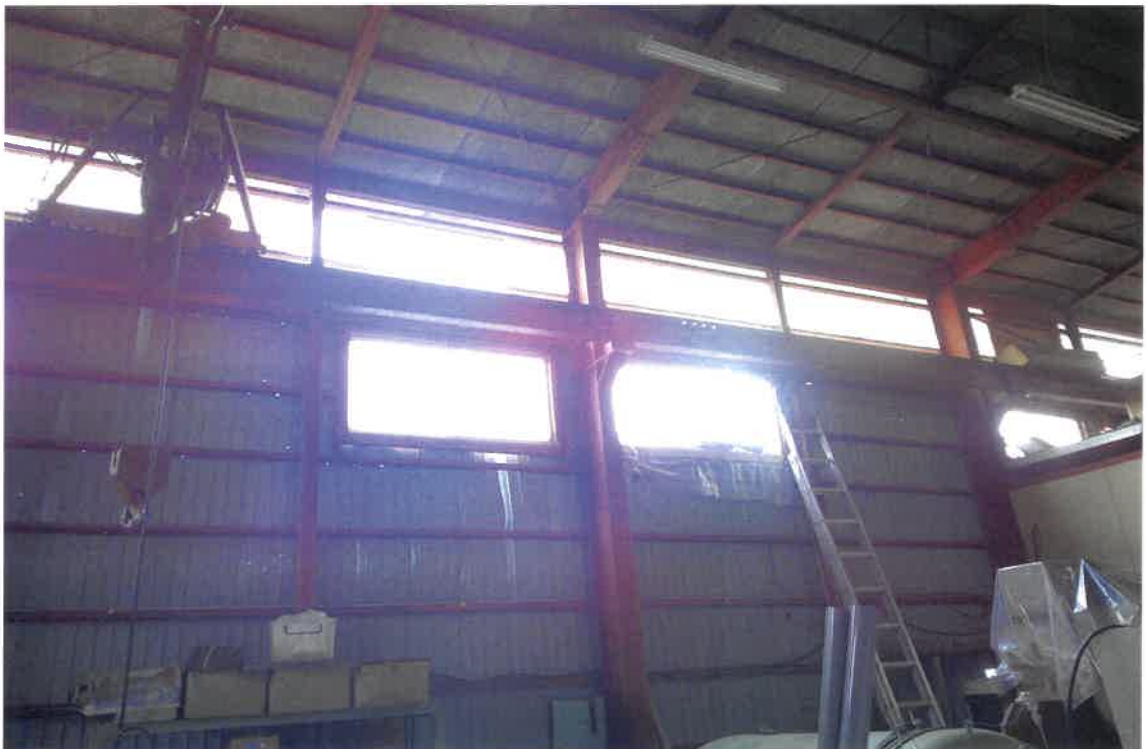
写真⑧(物件3 1階 作業場壁)
