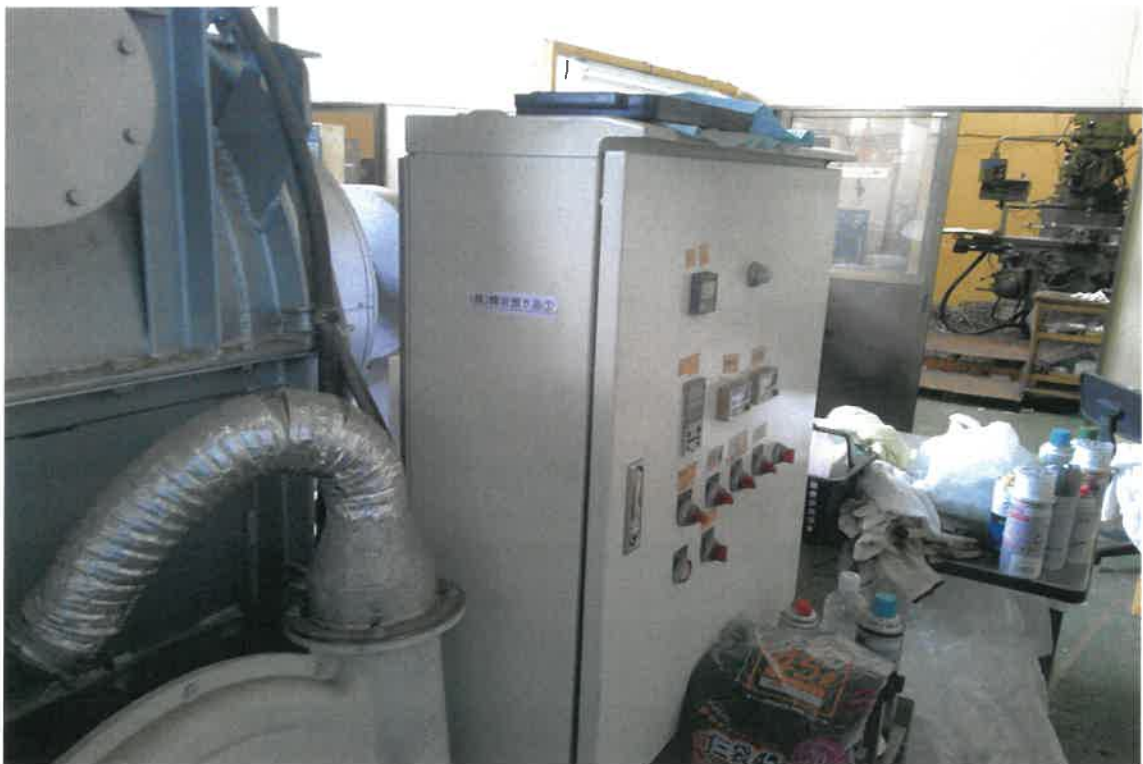
写真⑩ (物件3 1階 作業場)
