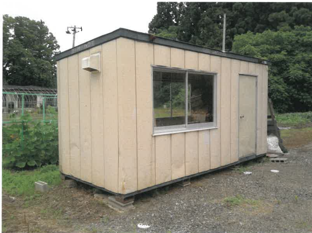
写真⑦ (物件 2 作業小屋)
