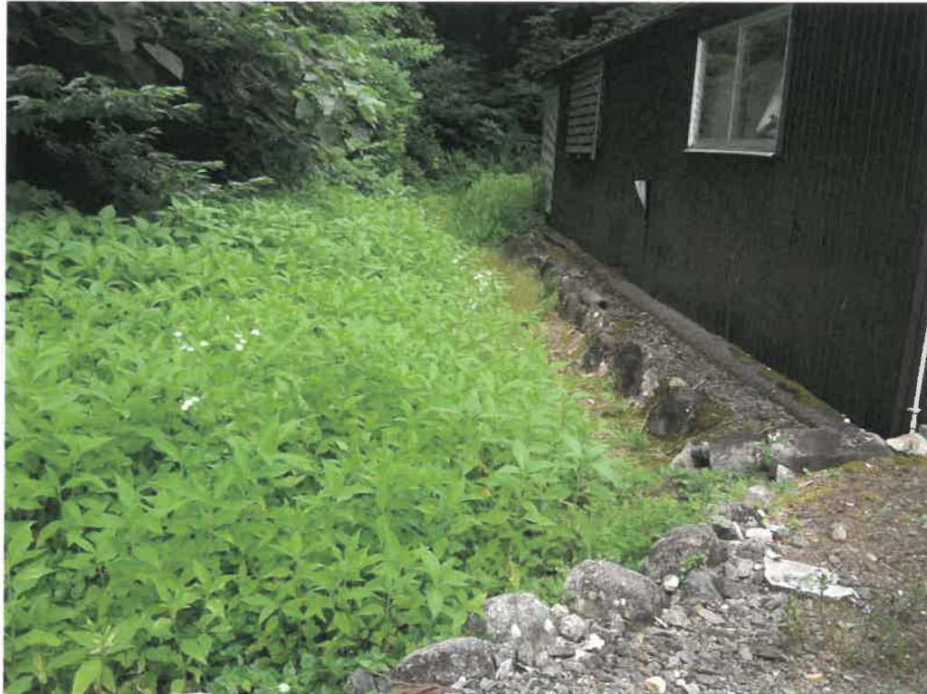
写真⑤ (物件2 北東側境界付近)
