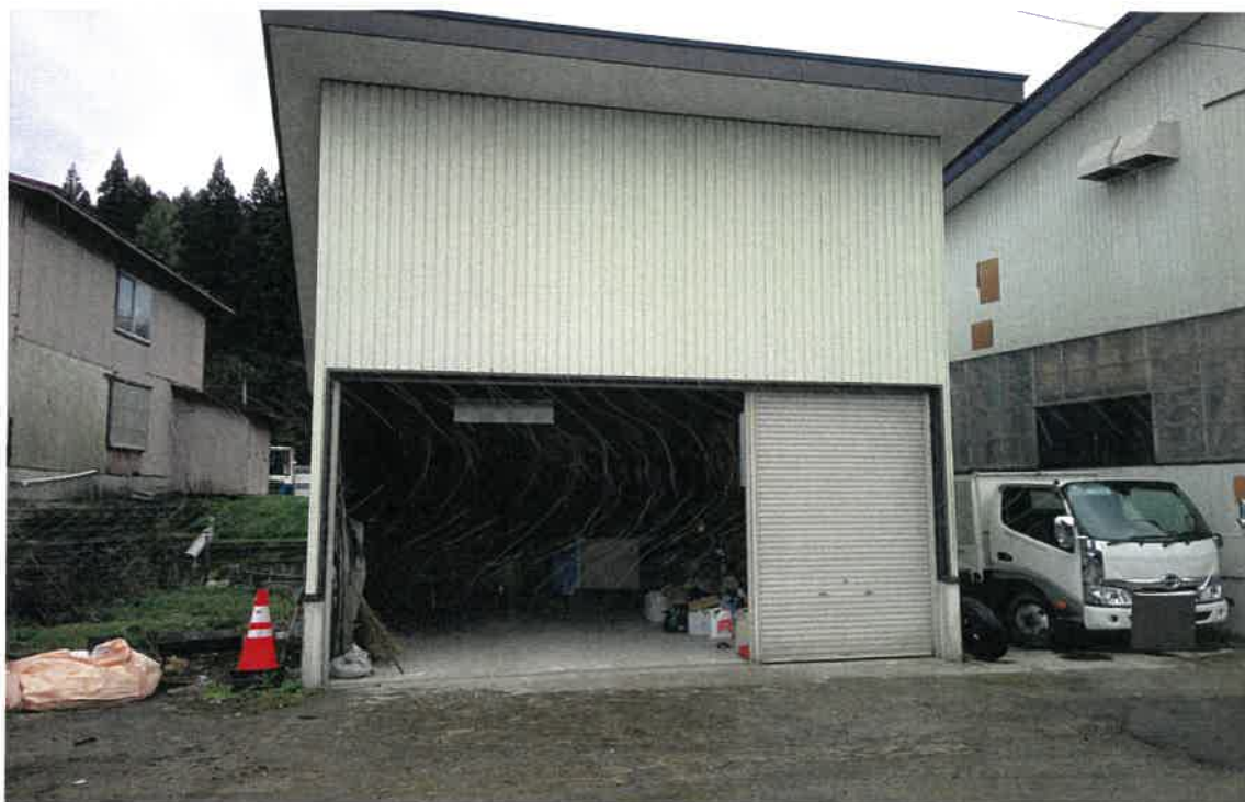
写真⑤(目的外未登記建物 1 外観)
