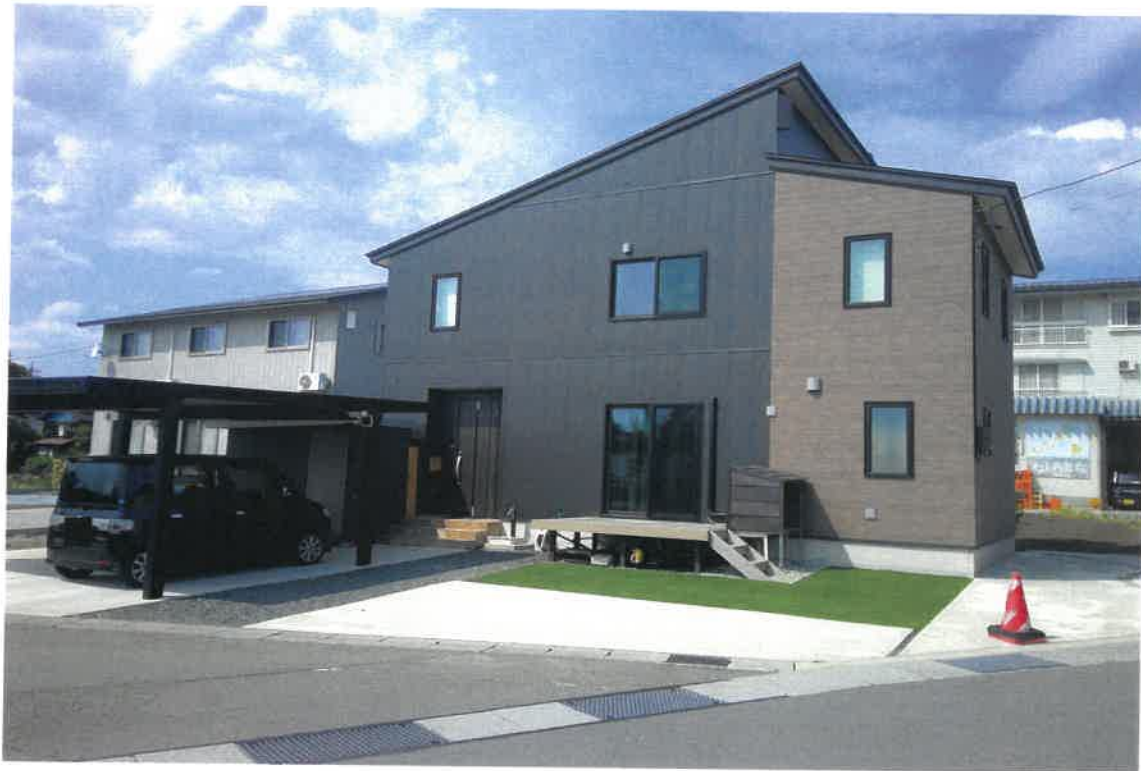
写真① (建物外観)
