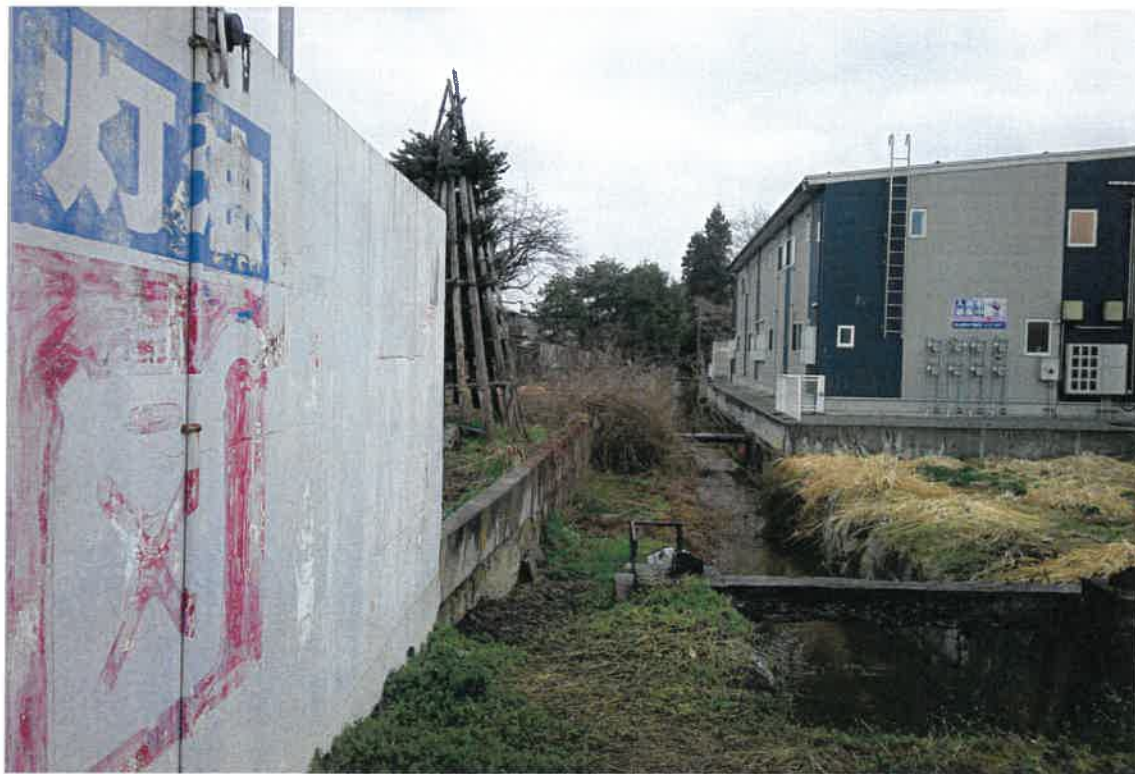
写真⑩ (物件 1 及び 2 南側水路付近)
