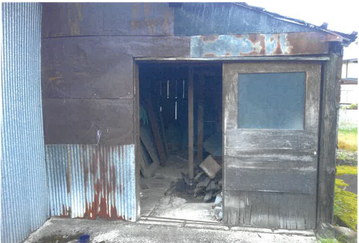
写真④(物件3 北側入口付近 )
