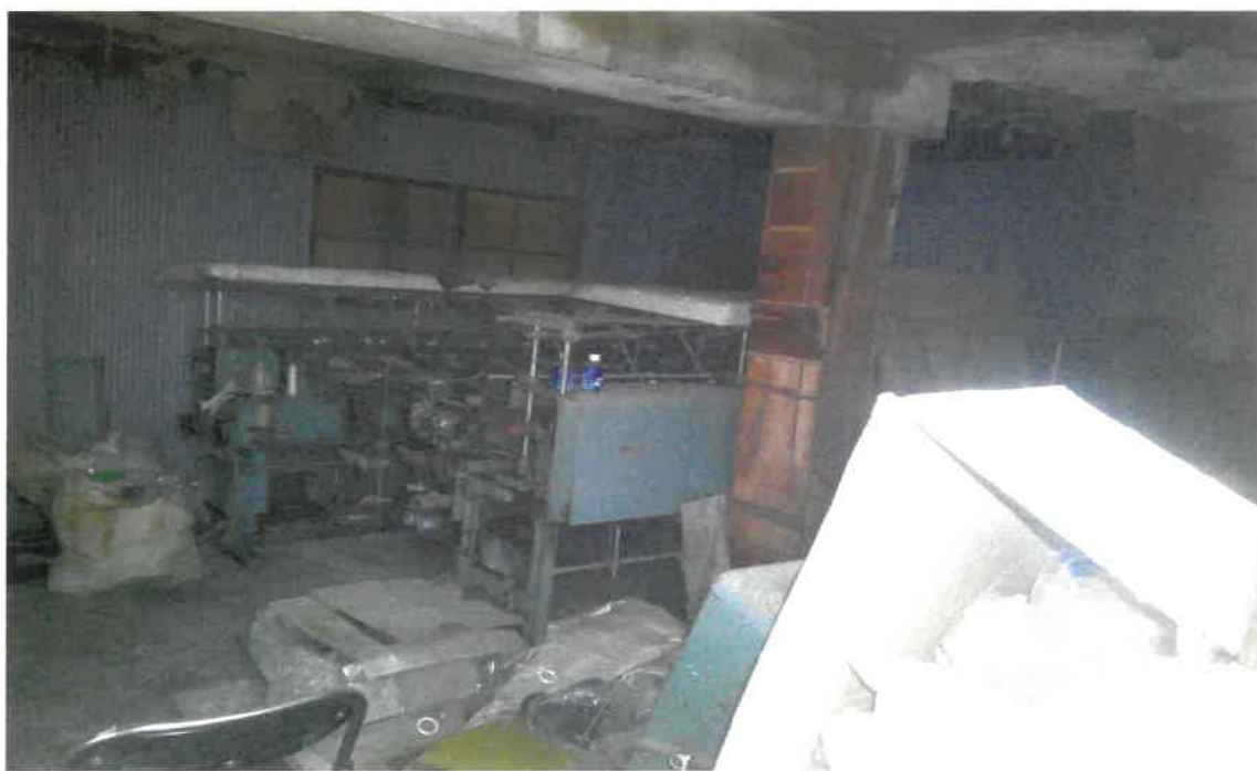
写真⑥ (物件 3 中央部分内部)
