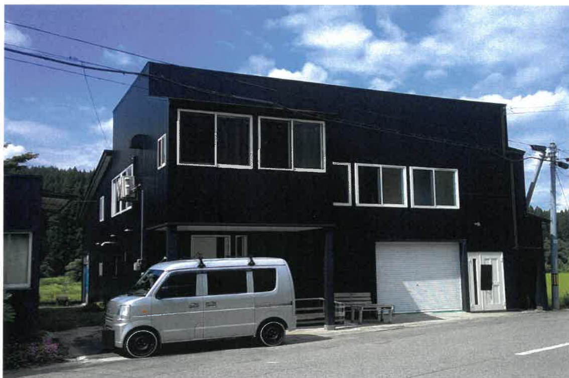
写真②(物件 2 附属建物(符号 1)建物外観)
