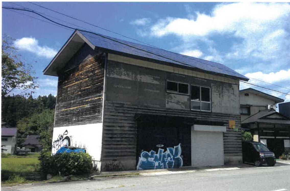
写真③(物件 2 未登記附属建物外観)
