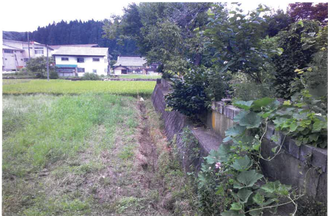
写真⑥(目的外土地南側境界付近)
