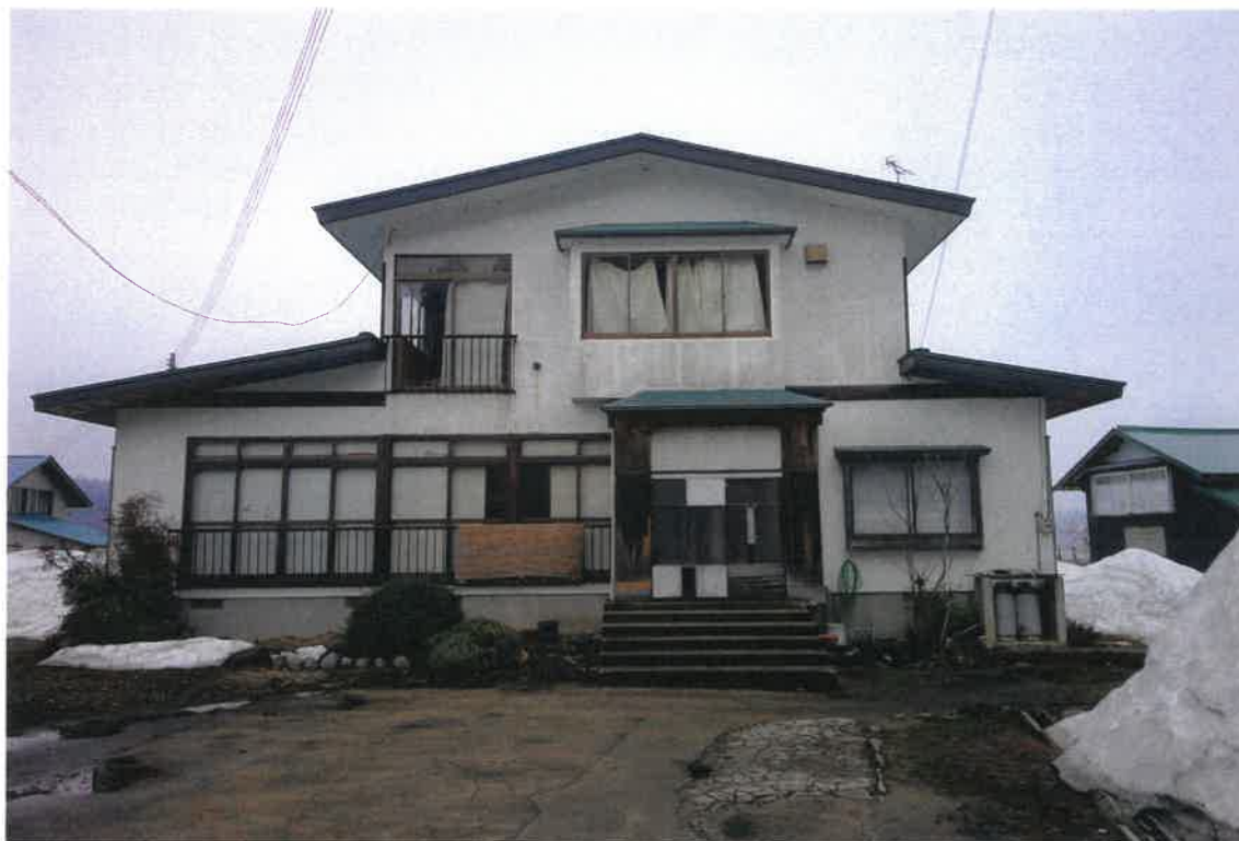
写真①(建物外観)
