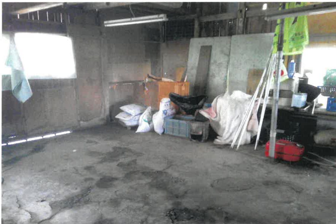
写真⑨ (仮設物置 建物内部)
