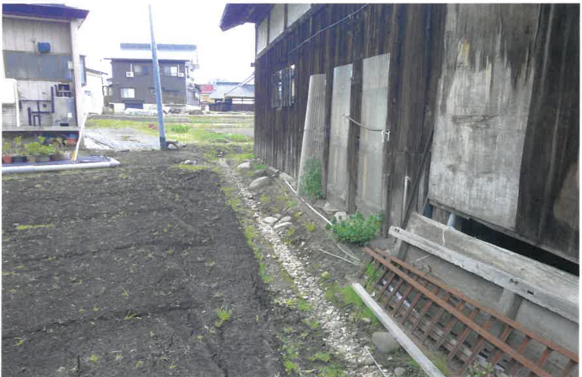
写真⑧ (仮設物置 側面部分)
