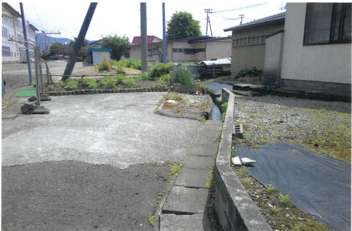
写真② (物件 1 南側境界付近)
