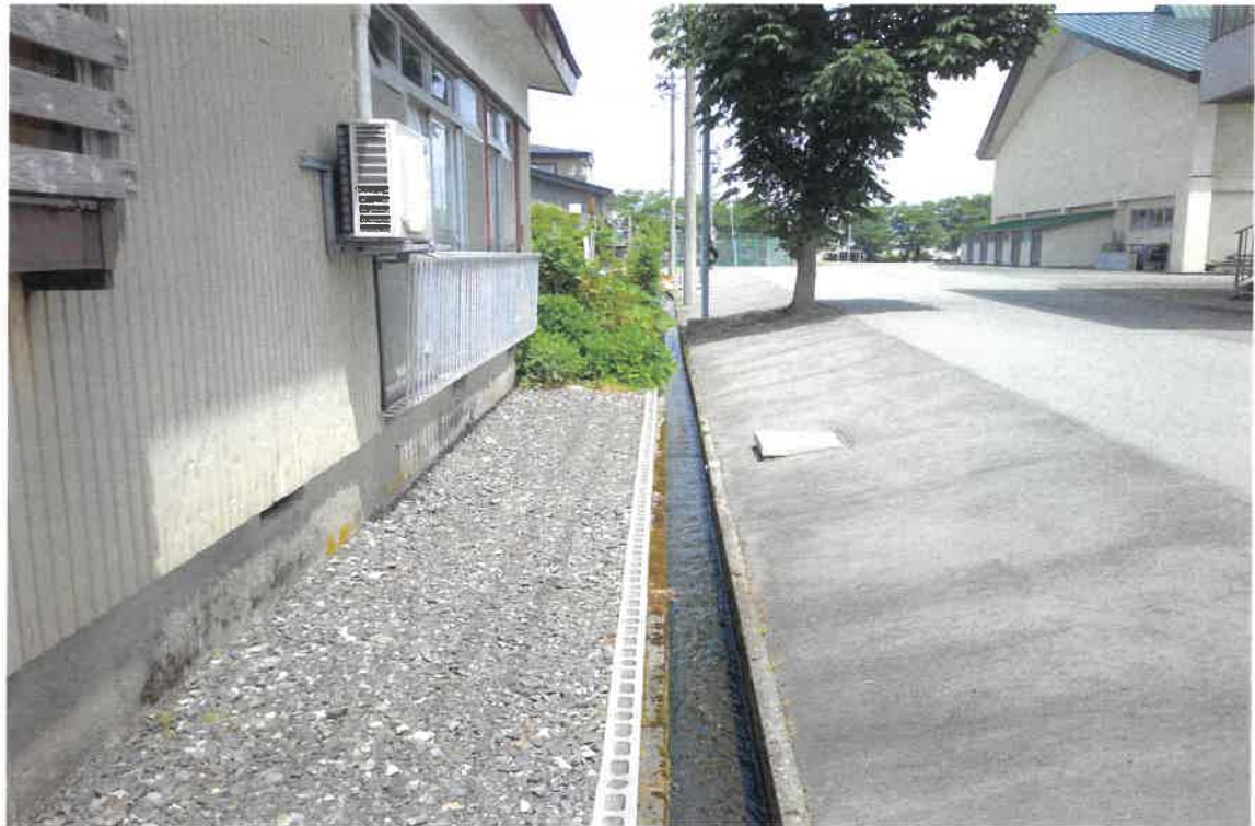
写真③(物件1 東側境界付近)
