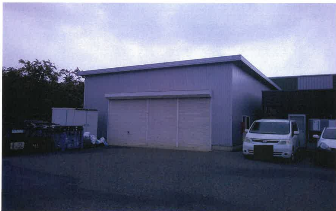
写真②(物件 2 附属建物外観)
