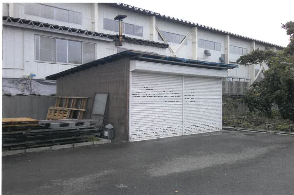
写真④(物件1 仮設物置)
