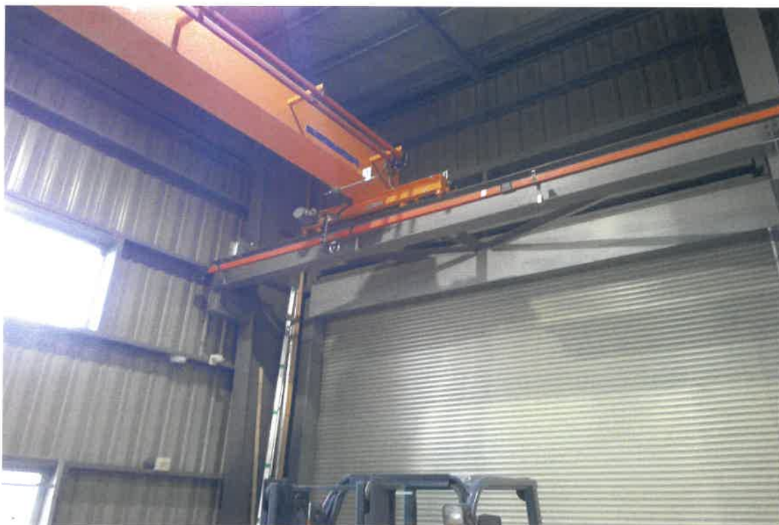
写真⑭(物件 3 建物内部)
