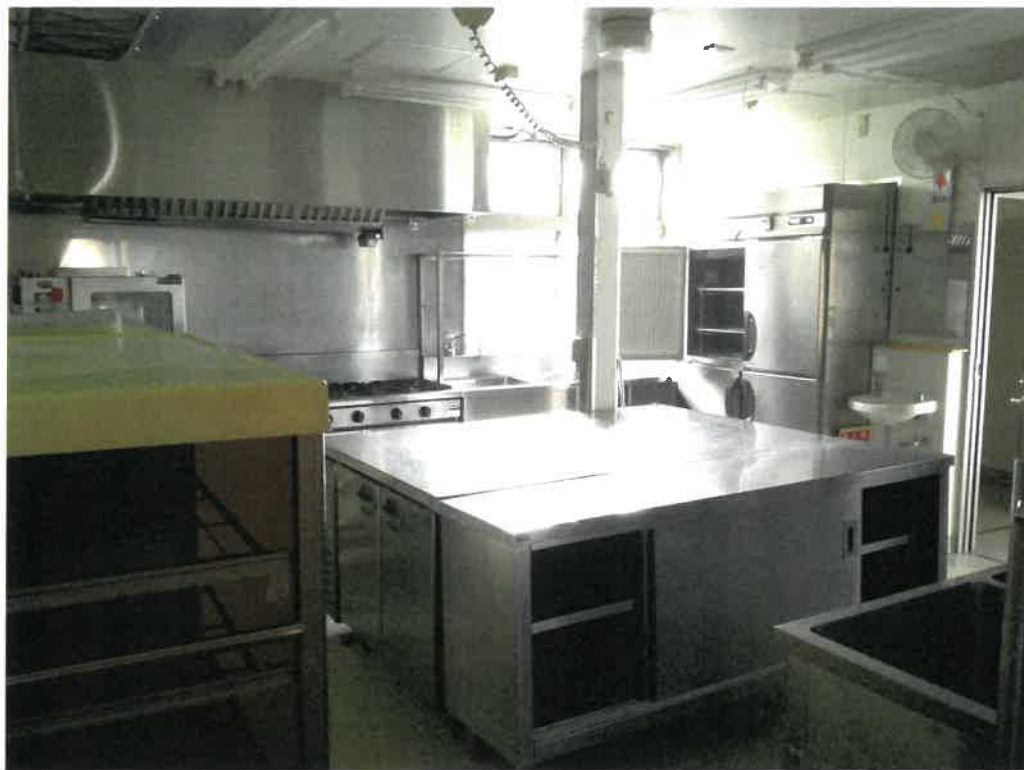
写真⑨ (物件 7 1階 厨房)
