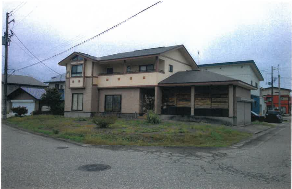
写真①(建物外観)
