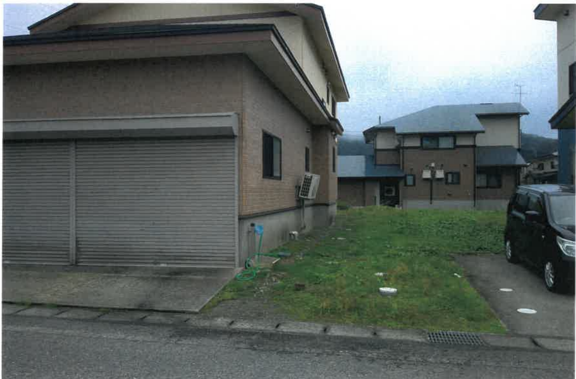
写真②(物件 1 北西側境界付近)
