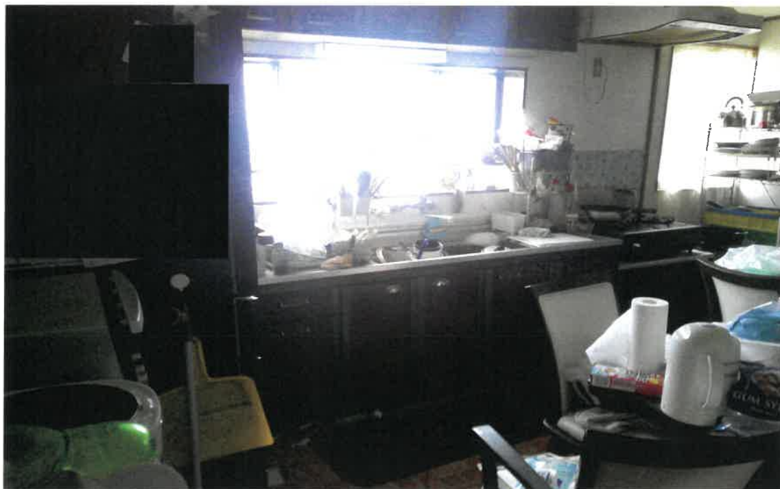
写真④(物件1 1階 キッチン)
