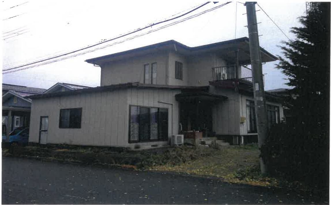
写真①(建物外観)
