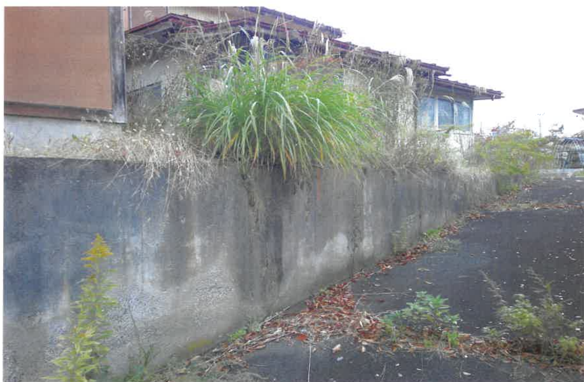
写真② (物件3 東側境界付近)
