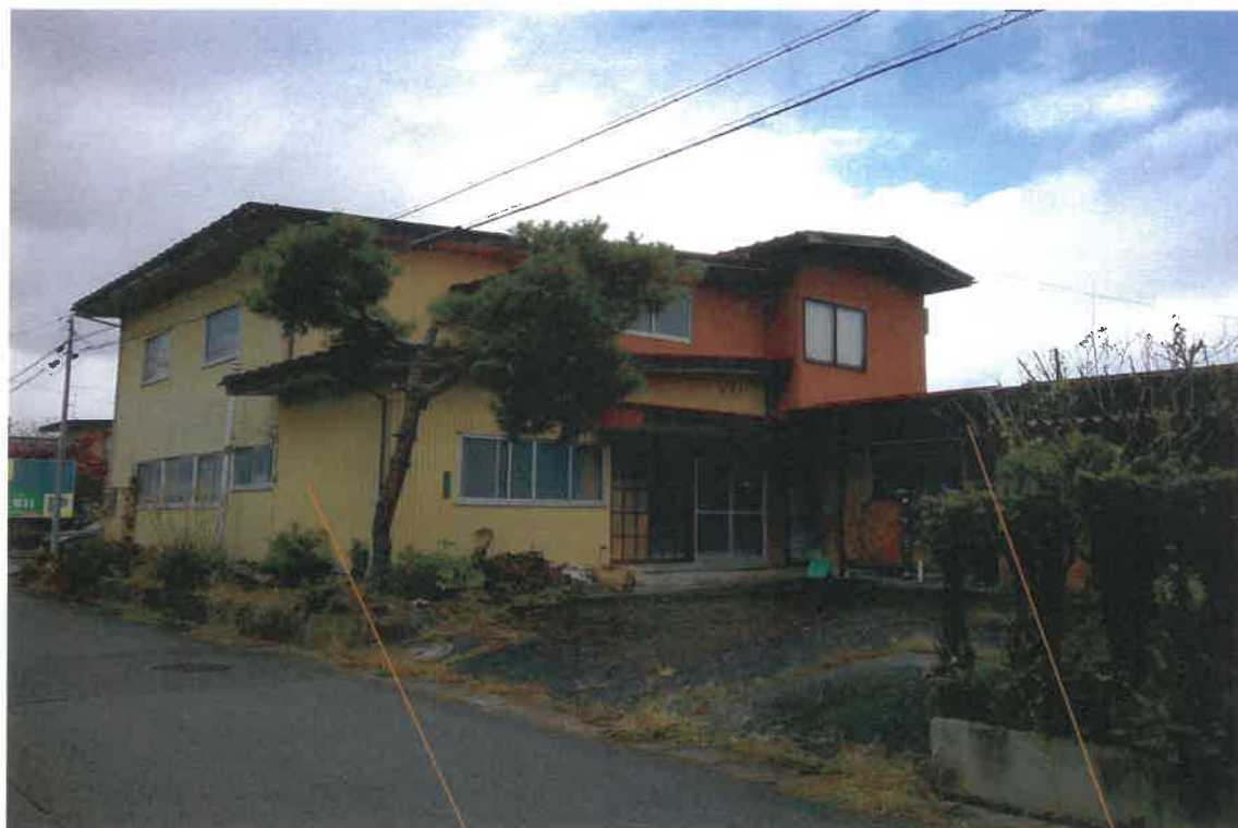
写真① (建物外観)
