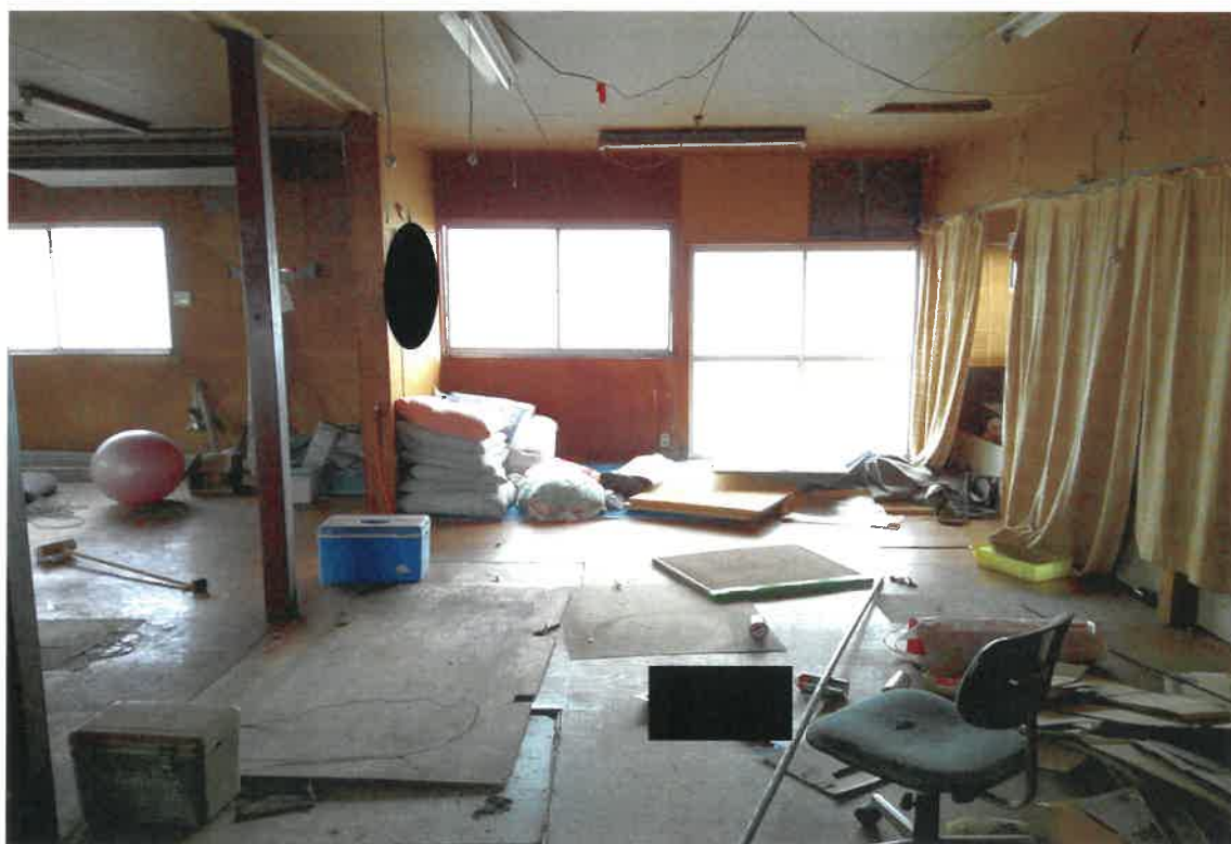
写真④(物件4 1階 作業場東側)
