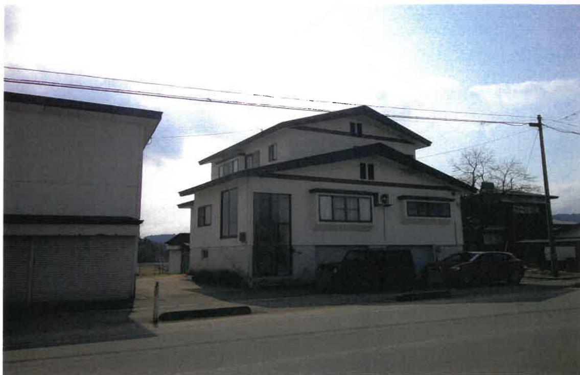
写真① (建物外観)
