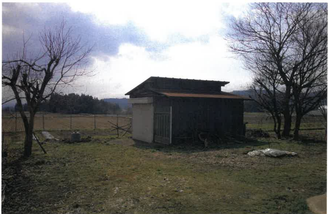
写真⑥ (仮設物置)
