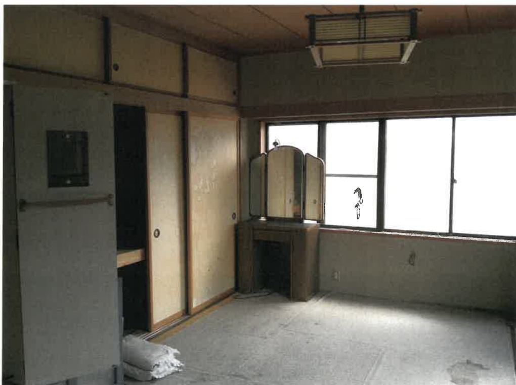
写真⑫ (物件4 2階 居宅 和室)
