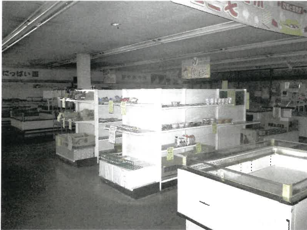
写真⑦(物件4 1階店舗(店内))
