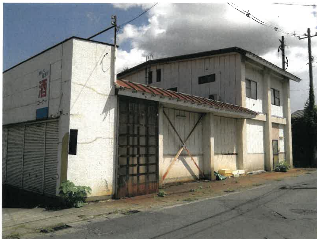
写真②(物件4 建物外観(店舗、住宅))
