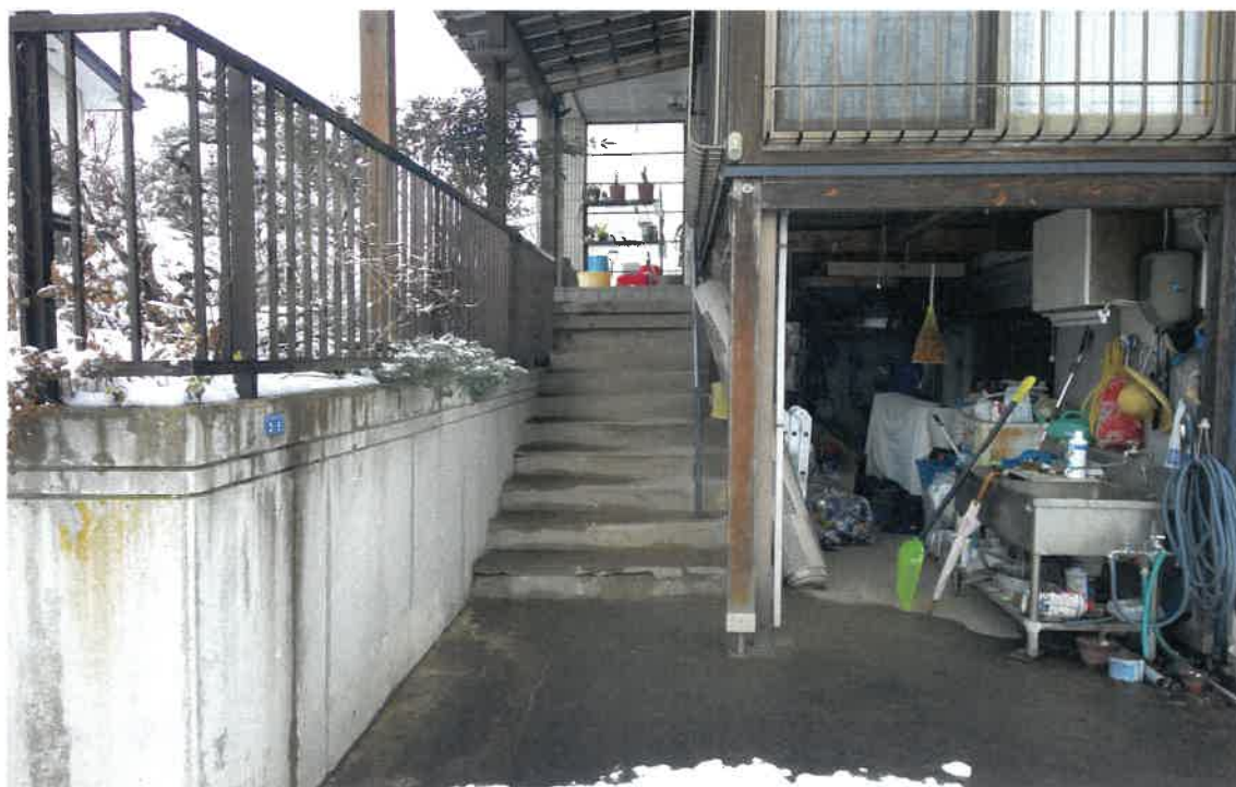
写真②(物件2 1階 南側階段付近)
