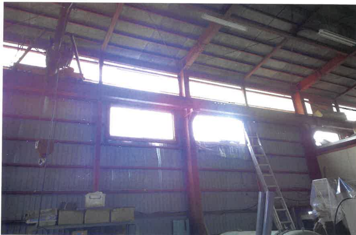
写真⑧(物件3 1階 作業場壁)
