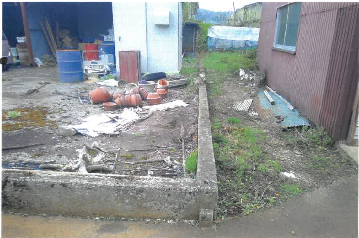
写真④ (物件 2 東側境界付近)
