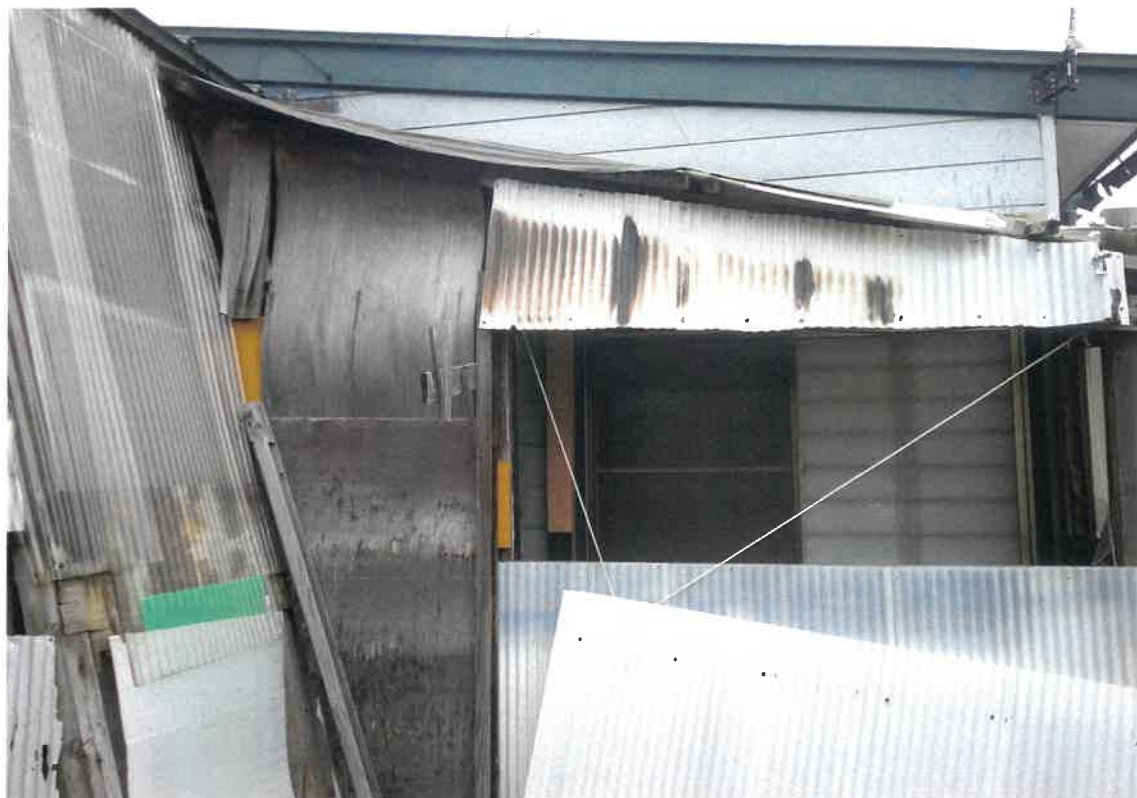
写真⑦(物件3 下屋)
