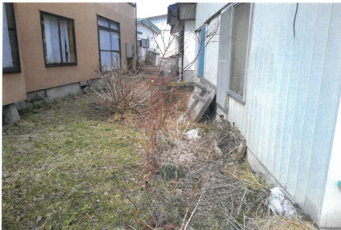
写真⑤(物件2 西側境界付近)
