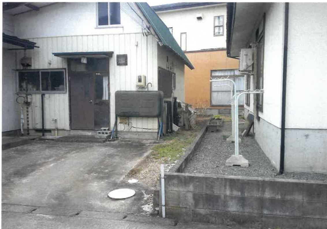
写真③(物件2 北側境界付近)
