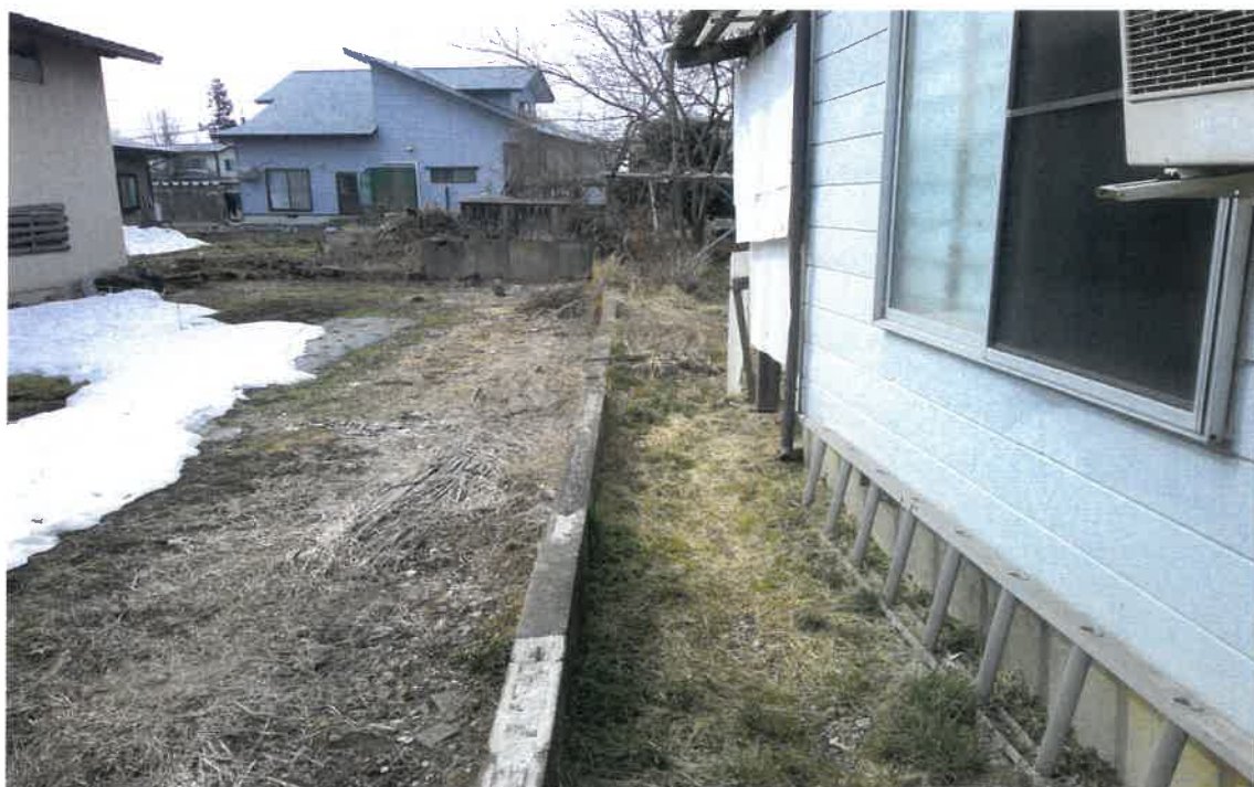
写真④(物件2 南側境界付近)
