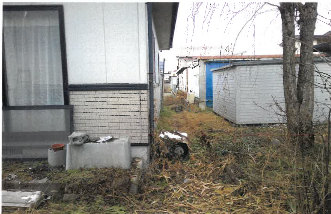
写真③(物件1 東側境界付近)
