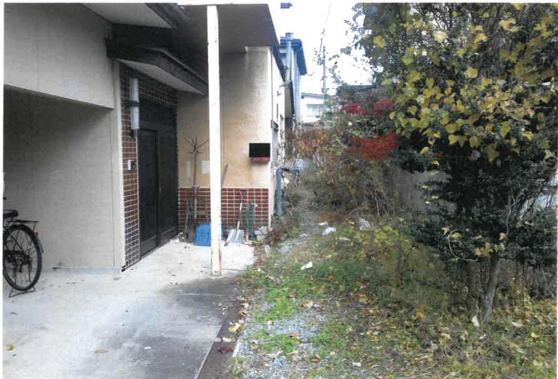
写真③(物件1 南東側通路付近)
