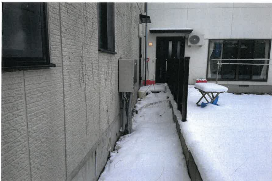
写真⑥(目的外土地 北東側境界付近)
