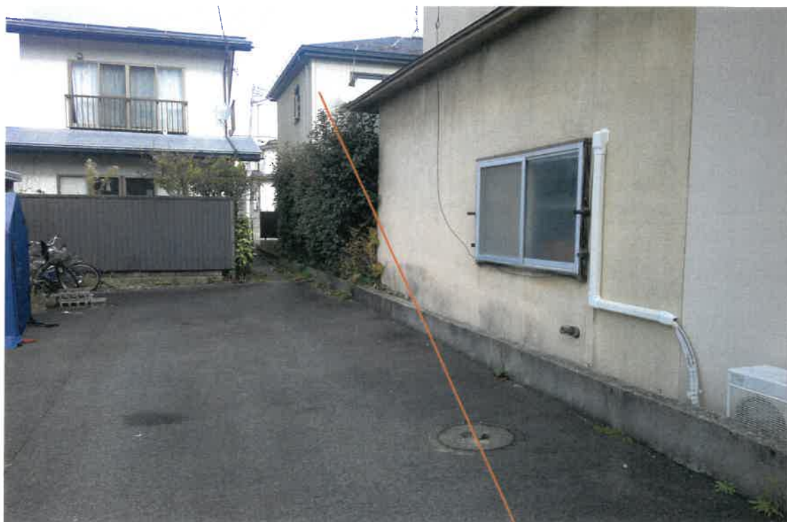
写真②(物件1 北西側境界付近)
