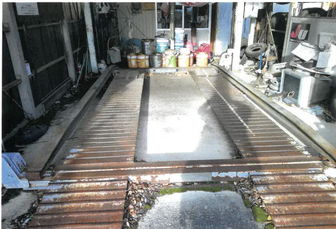
写真⑮(物件3 南側 工作物(作業場)付近)
