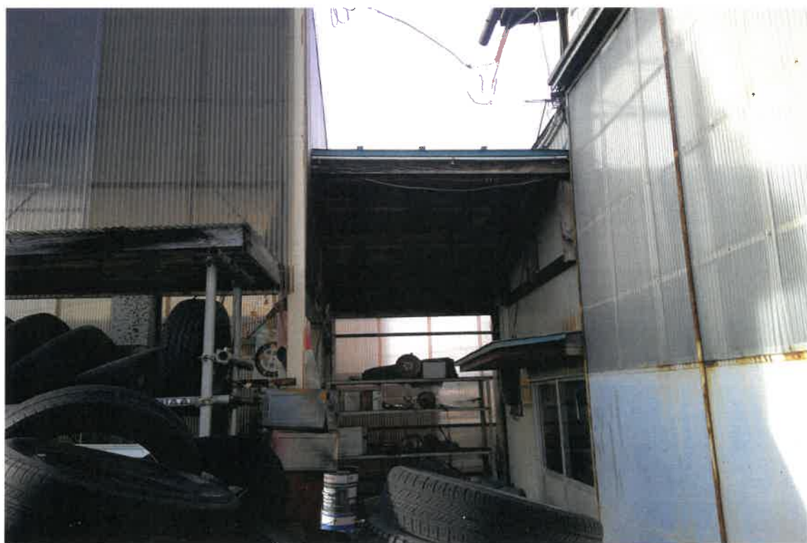
写真⑭(物件 3 南側下屋付近)
