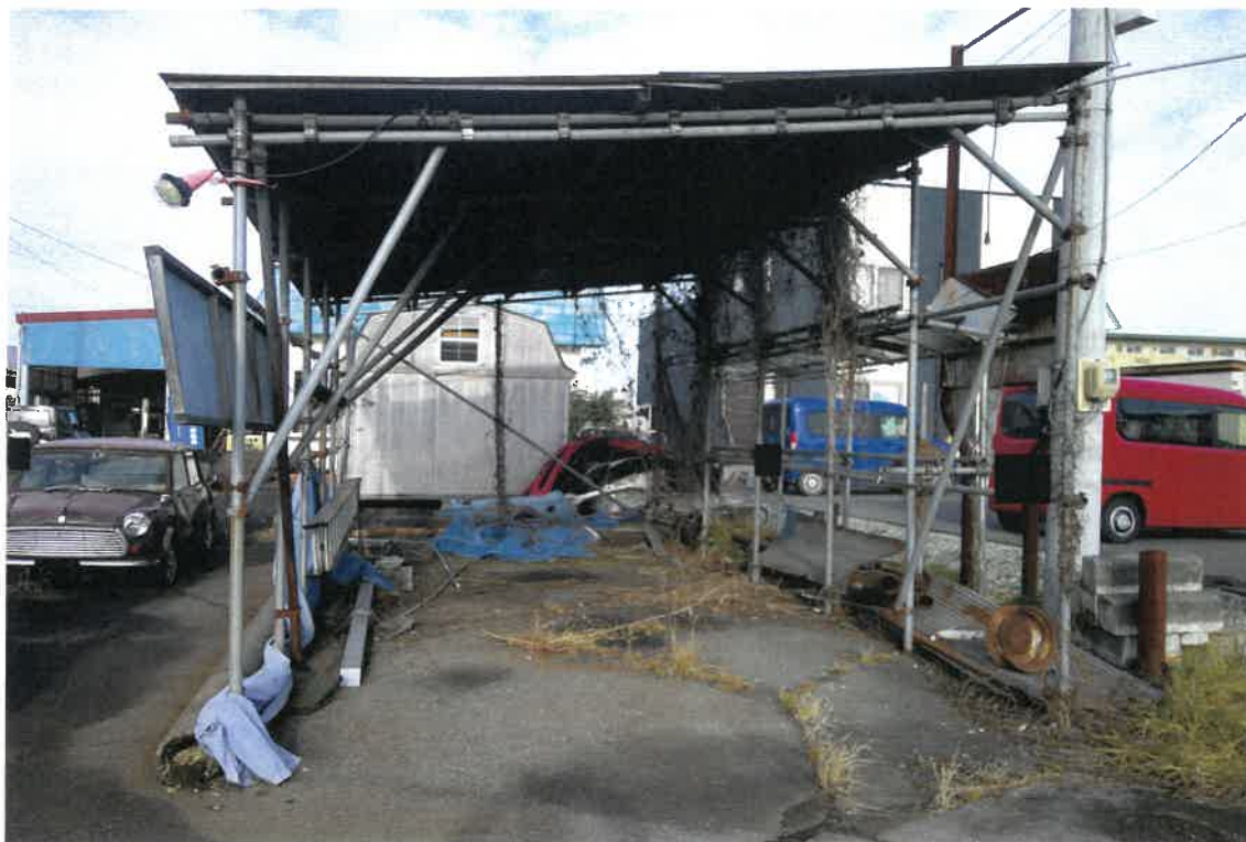
写真⑤(物件1 南側 仮設物(物置)付近)
