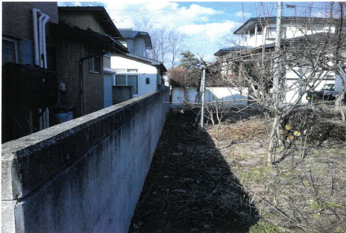
写真⑤(物件3 南側境界付近 コンクリートブロック塀)
