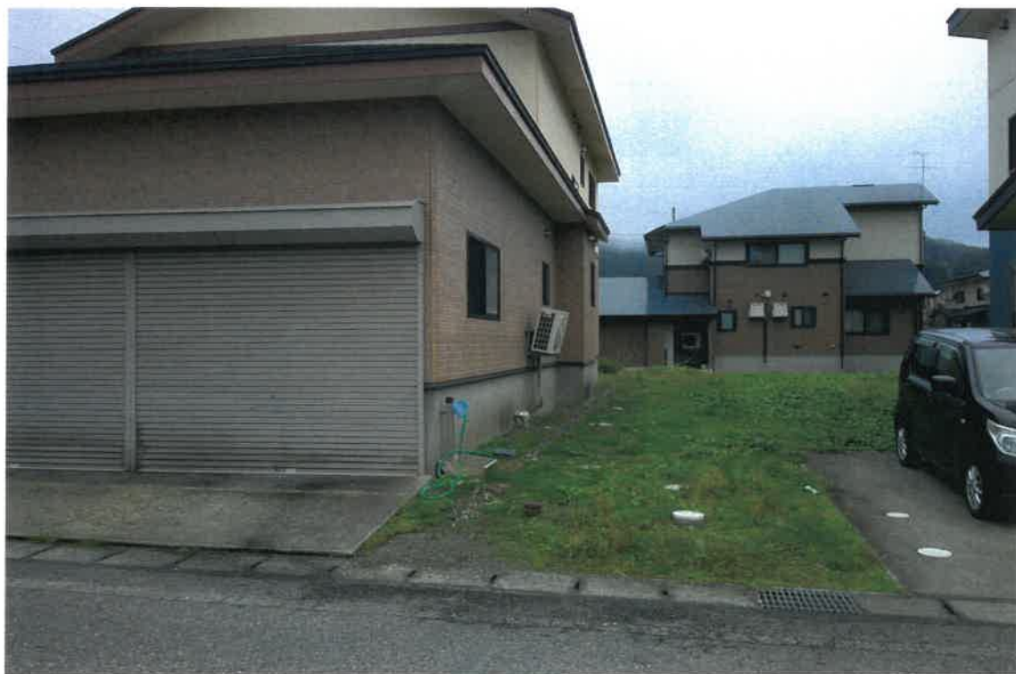
写真②(物件1 北西側境界付近)
