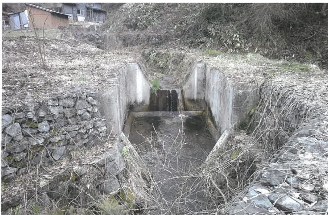
写真⑭(物件1 東側水門方向を撮影)
