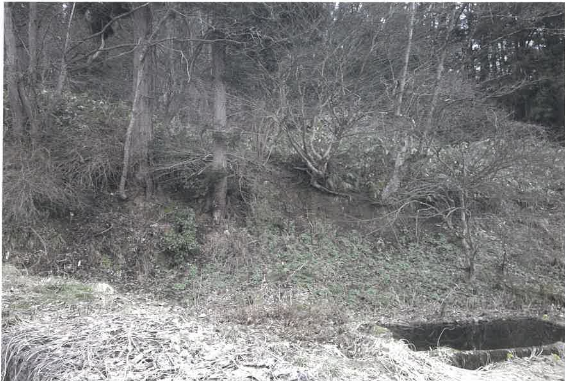
写真⑬(物件1 南側境界付近 崩れた斜面あり)
