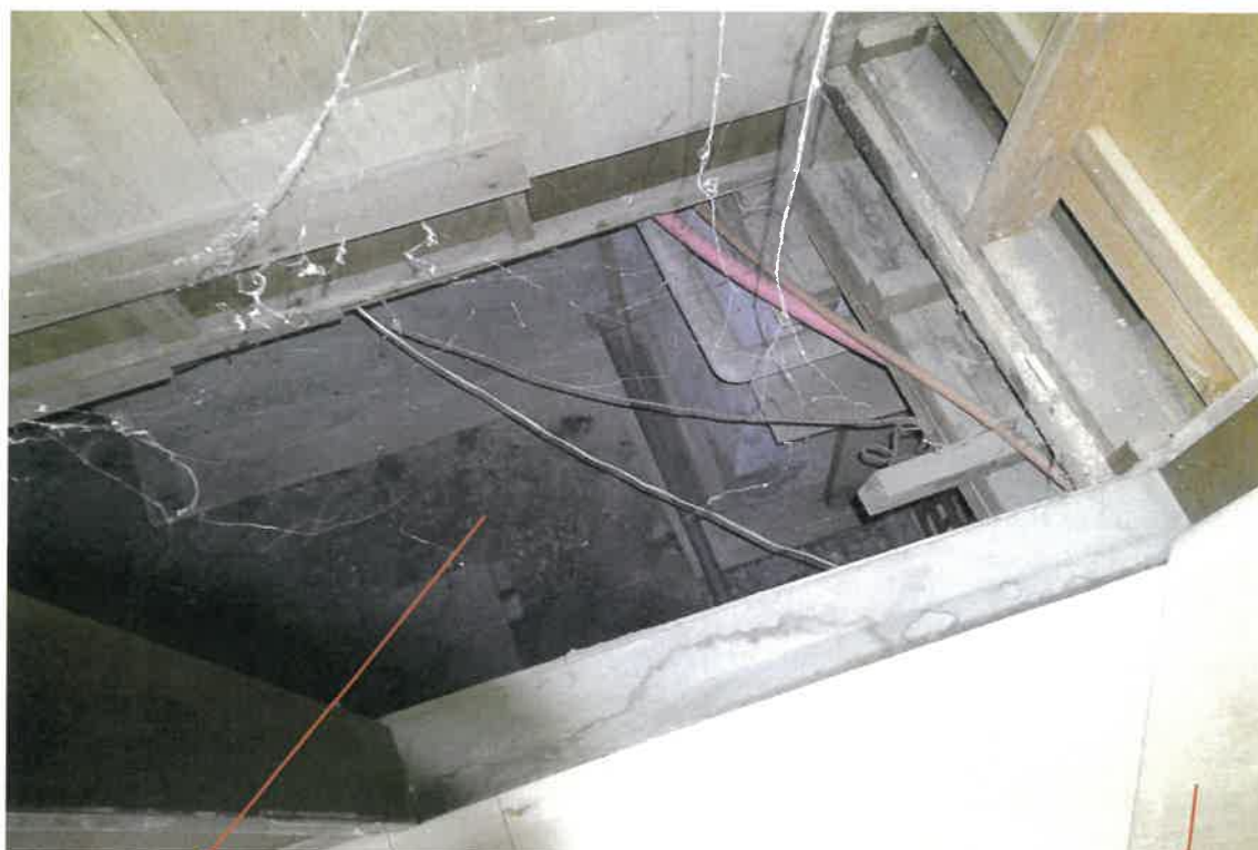
写真⑯(物件2 中2階 1階車庫兼物置に通じる箇所)
