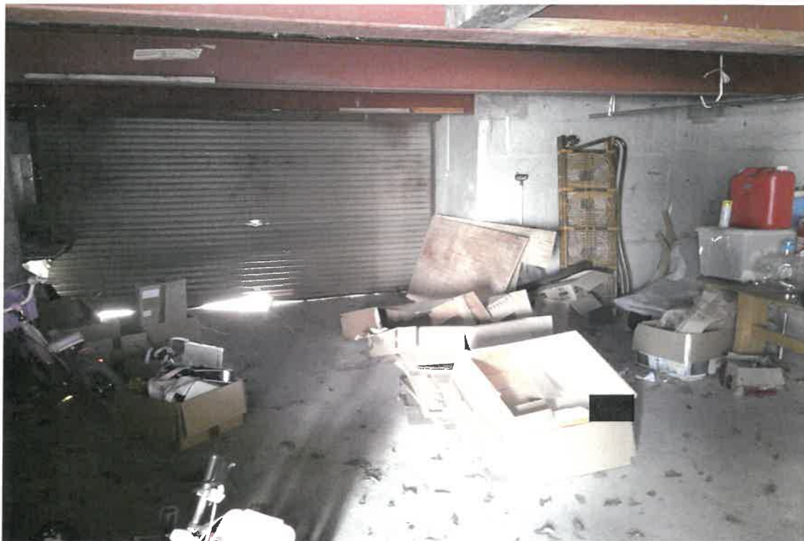
写真⑥(物件2 1階 車庫兼物置)
