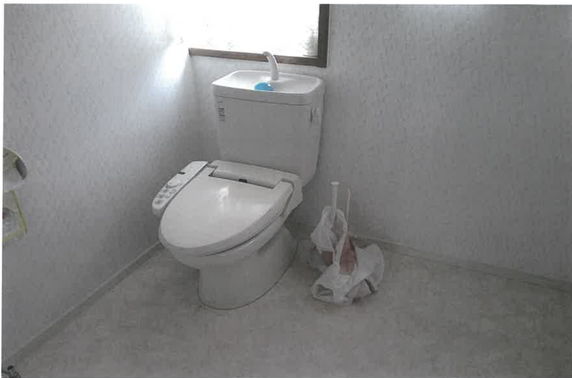
写真⑮(物件2 中2階 トイレ)
