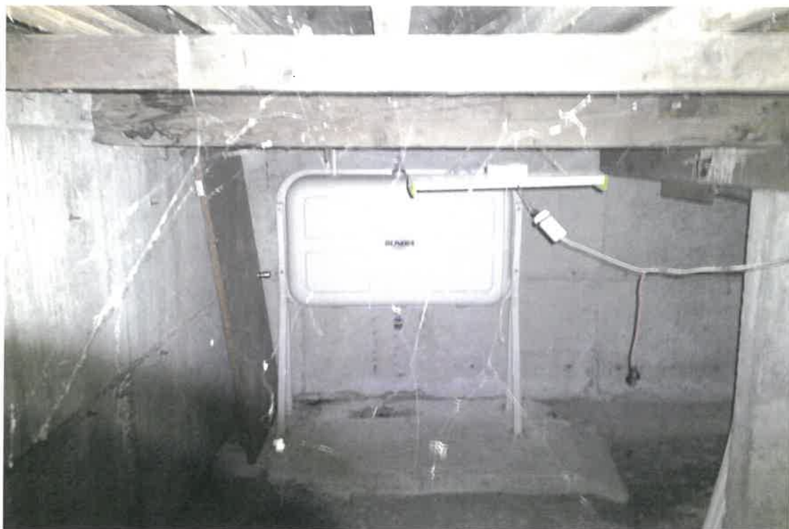
写真⑧(物件2 1階 車庫兼物置 最深部)
