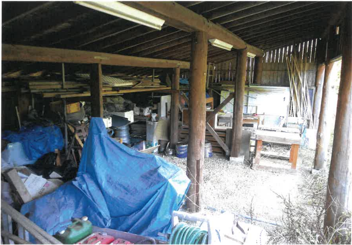
写真⑬ (物件 4 附属建物内部)
