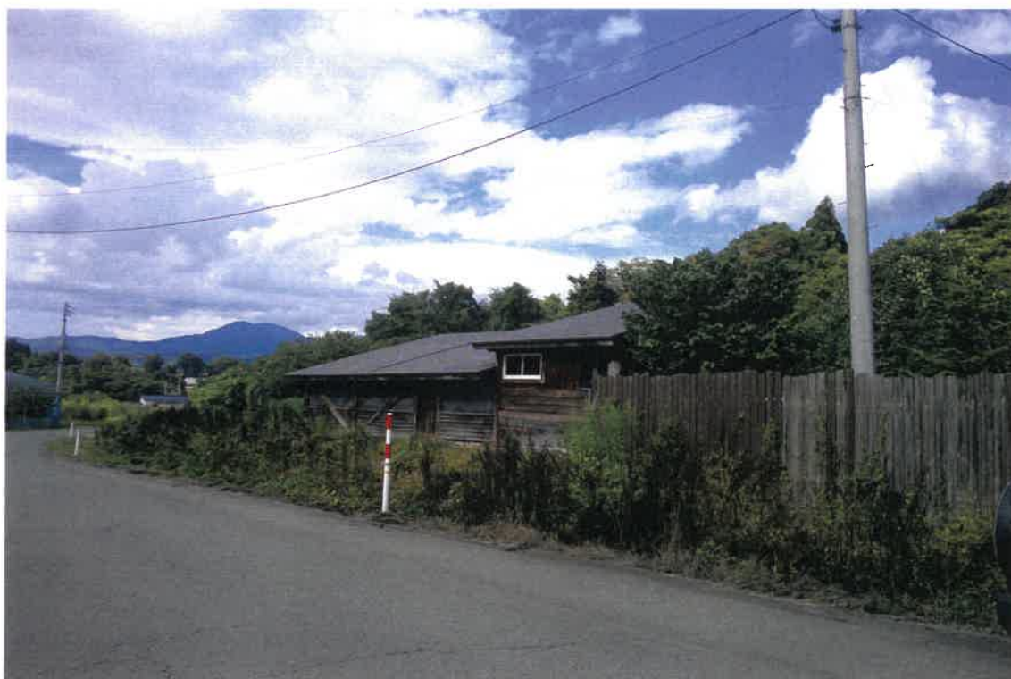
写真②(建物外観 物件4 附属建物)
