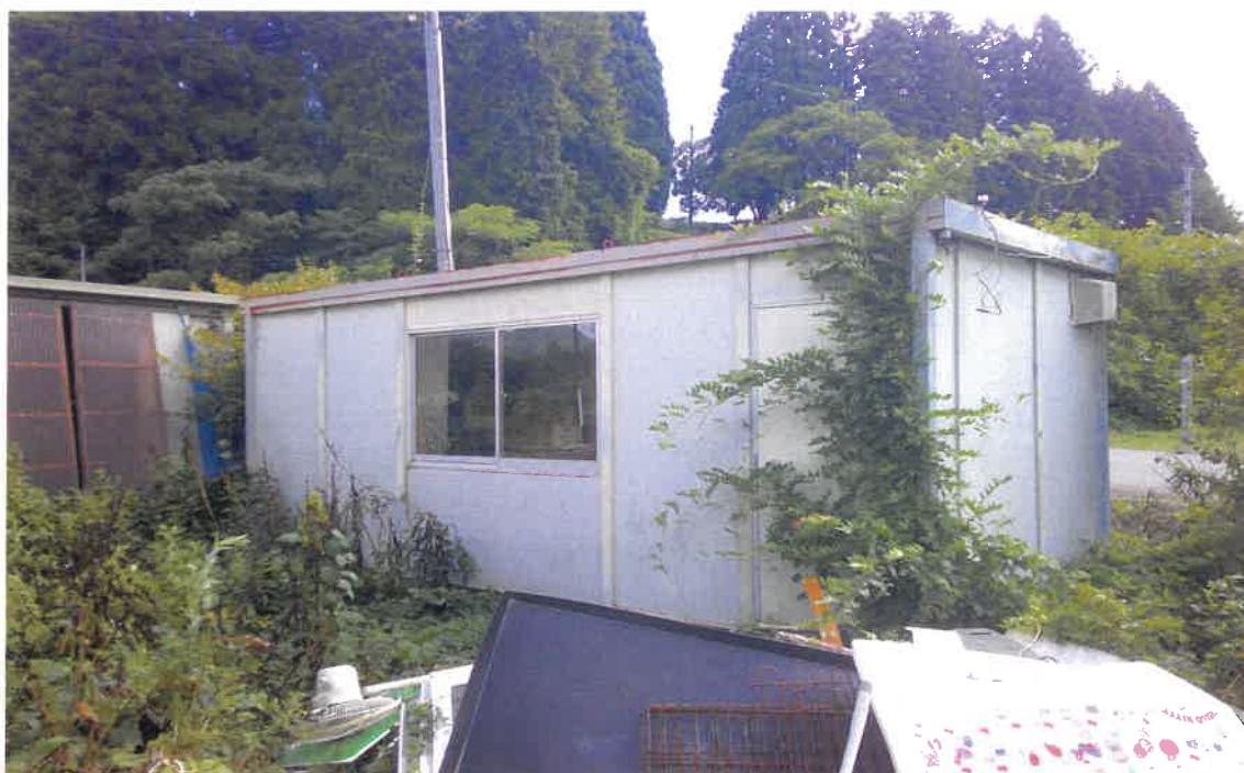
写真⑧(仮設物置)
