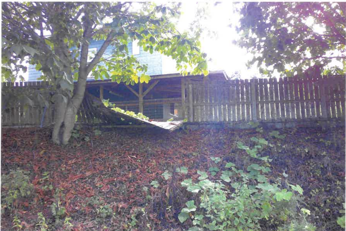
写真④(物件1 東側法面上部柵付近)
