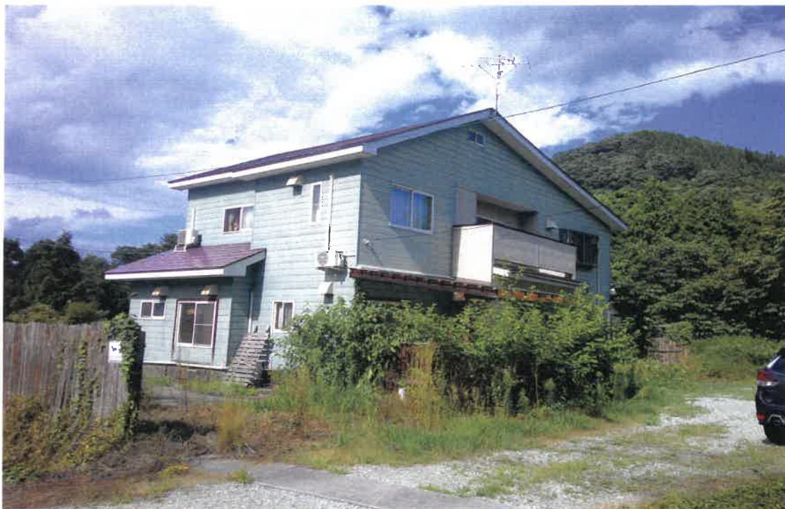
写真①(建物外観 物件4)
