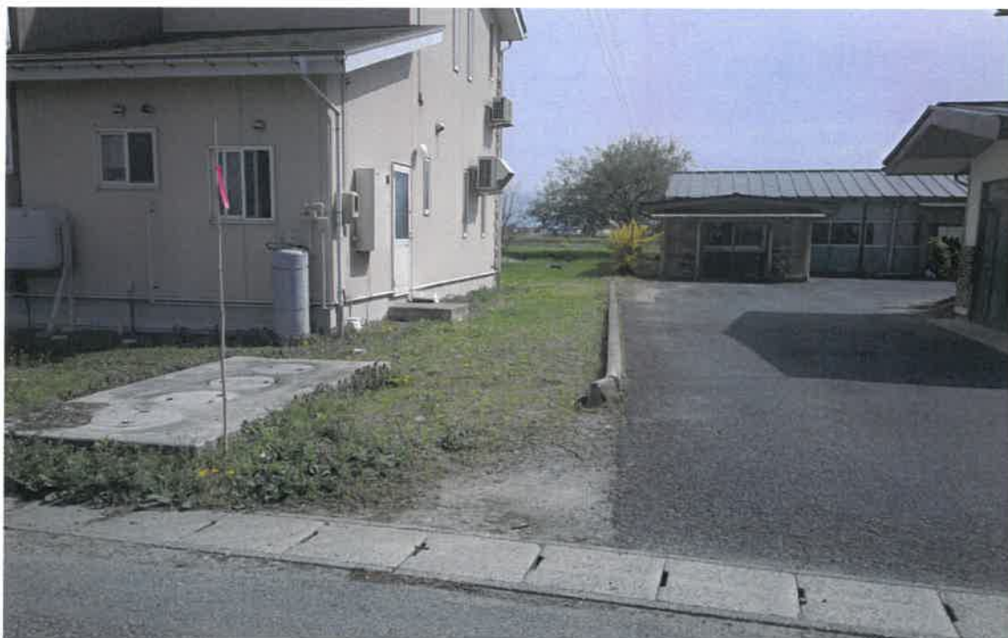
写真②(物件 1～4 西側境界付近)
