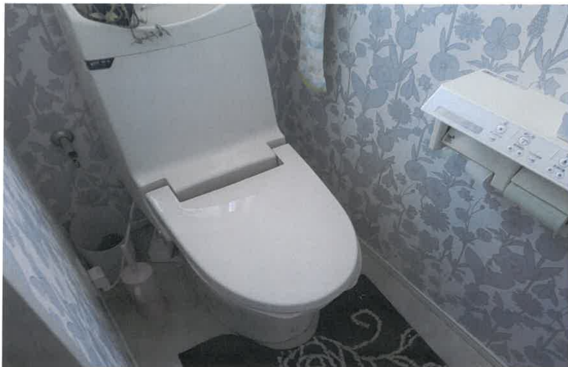
写真⑪(物件5 1階 トイレ)
