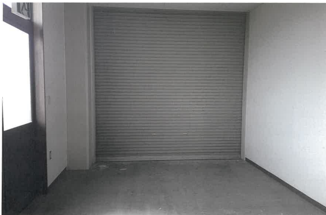
写真②⑧(物件4 1階 倉庫)
