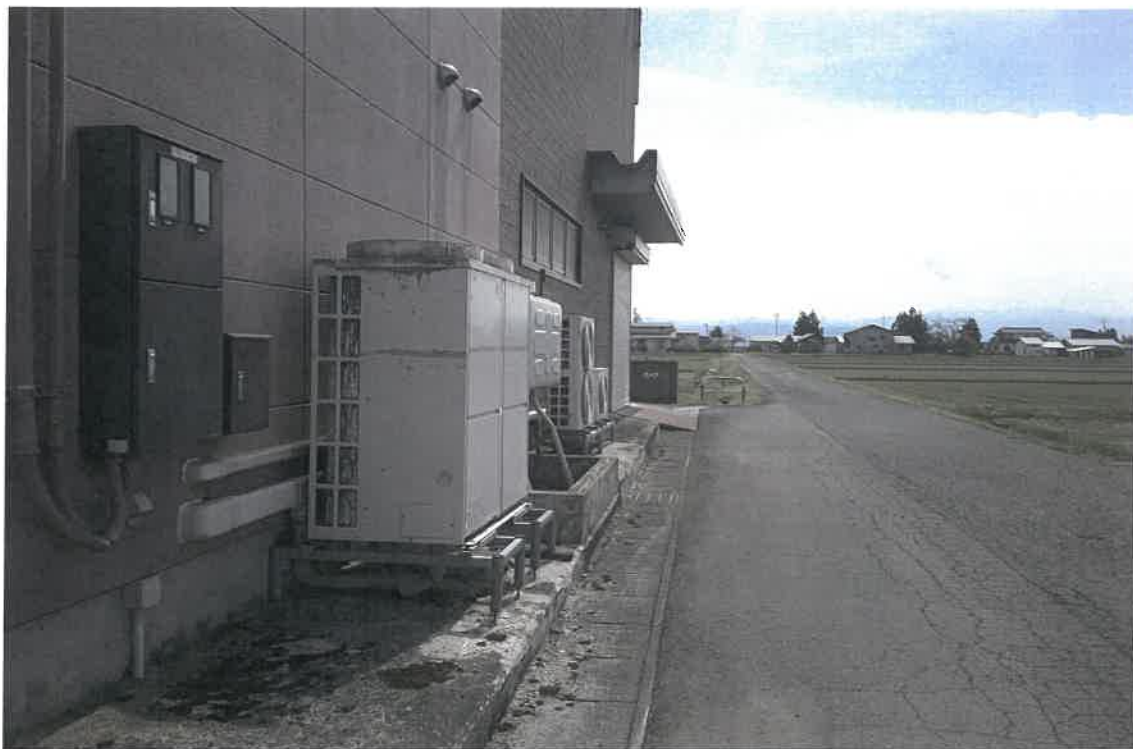
写真③(物件 2 西側接道付近)
