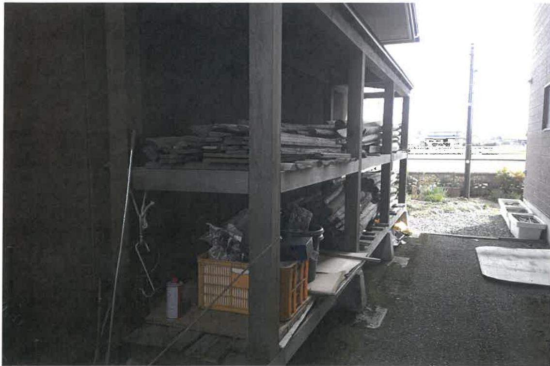
写真⑤(物件3 西側下屋付近)
