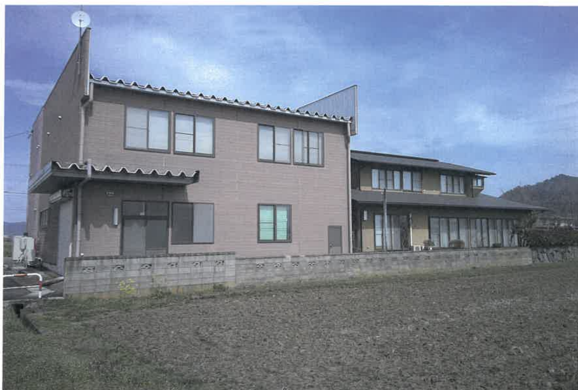
写真④(物件 1、2 南側境界付近)
