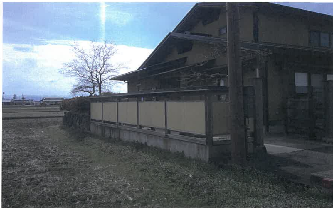
写真②(物件1 東側境界付近)
