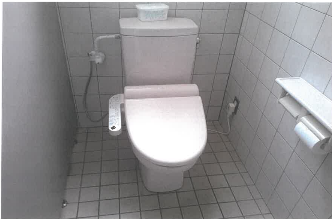
写真②⑦(物件4 1階 トイレ)
