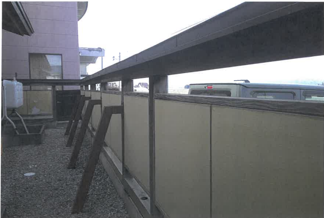
写真⑦(物件1 北側 板塀付近)
