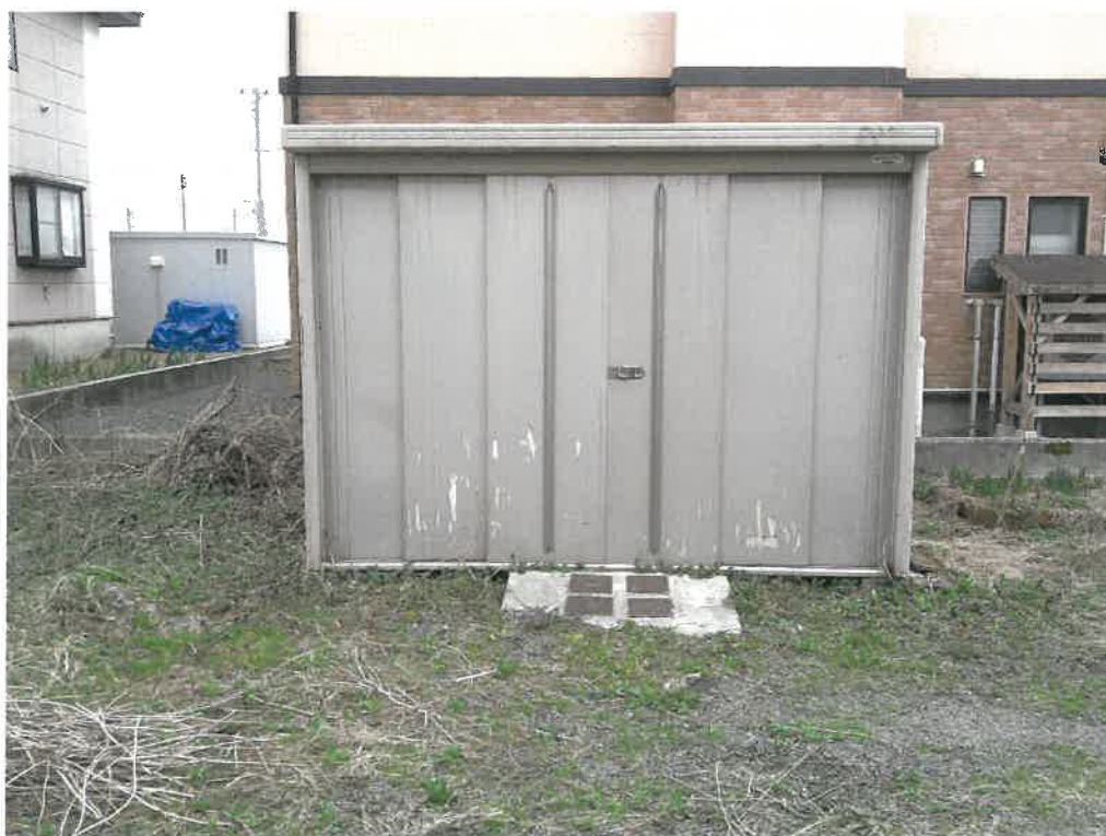
写真② (物件 1 スチール製物置)
